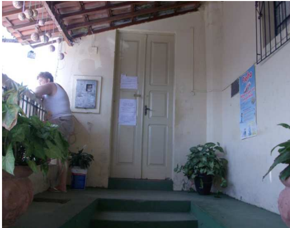
Figura 08: Escada de entrada
