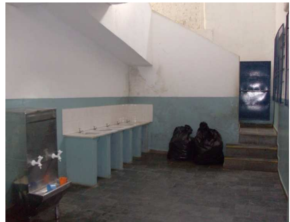
Figura 19: Bebedouros e lavatórios
