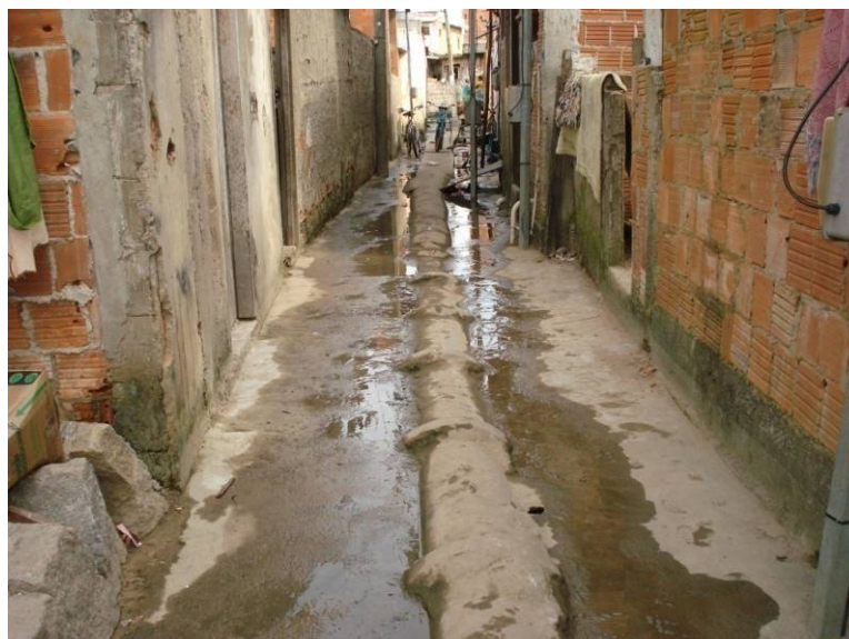
Figura 9: Manilhas construídas na Viela do bairro Jardim Carioca.
