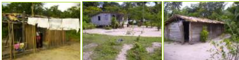
Figura 13, 14 e 15. Casas de moradia na localidade de São Raimundo
