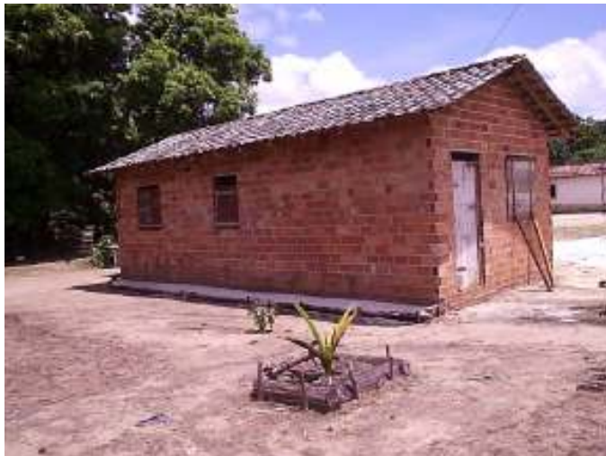
Fotografia 7 - Casa após a construção. Construída em sistema de mutirão Fonte: Regina Reis, em fevereiro de 2006
