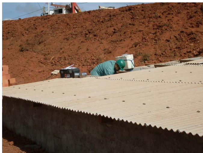
Figura 32: Monitoramento do efluente sanitário – coleta a montante do tanque séptico
