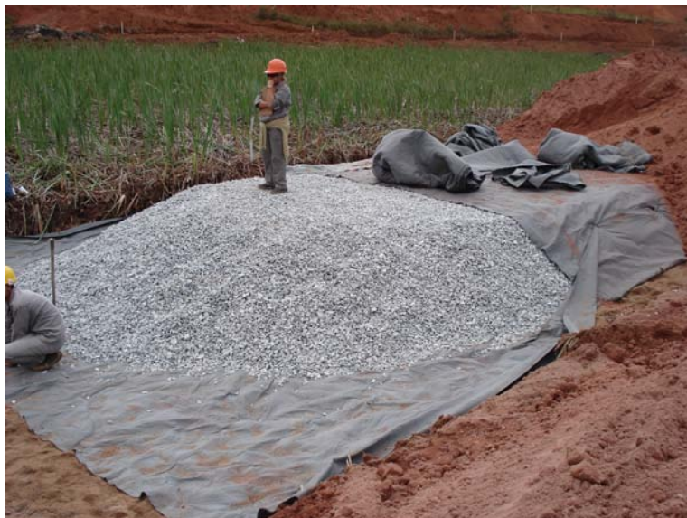
Figura 21: Detalhe do canal do dreno (brita revestida com a manta geotêxtil)
