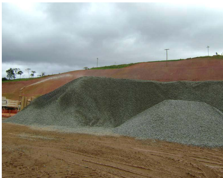
Figura 35: Aspersão de água nas pilhas de estocagem da Central de Concreto
