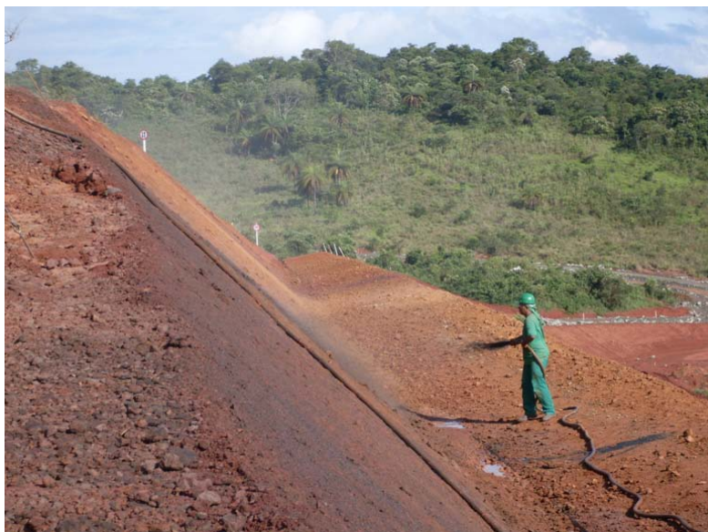
Figura 25: Hidrossemeadura dos taludes
