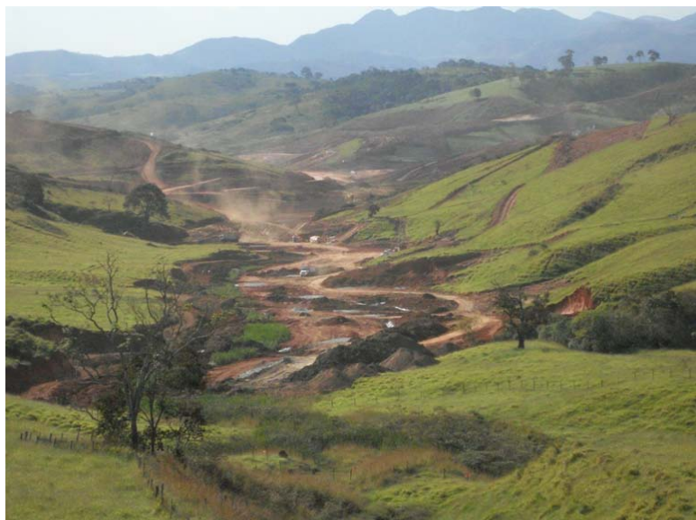
Figura 20: Drenagem subterrânea da área, retificação do córrego Barbeiro
