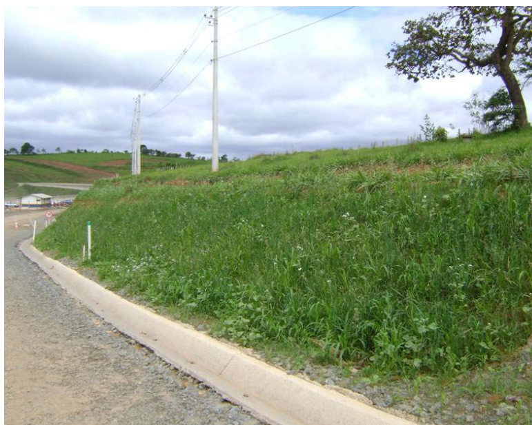
Figura 24: Valeta de proteção de aterro
