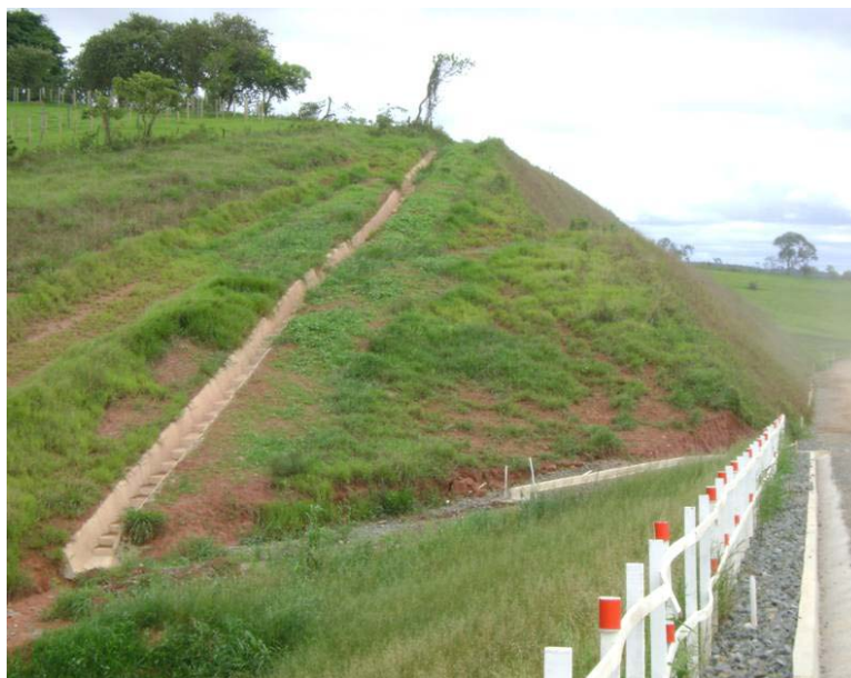
Figura 23: Valeta de proteção de corte
