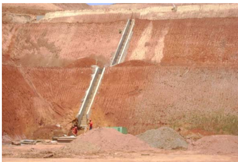
Figura 22: Descida d'água
