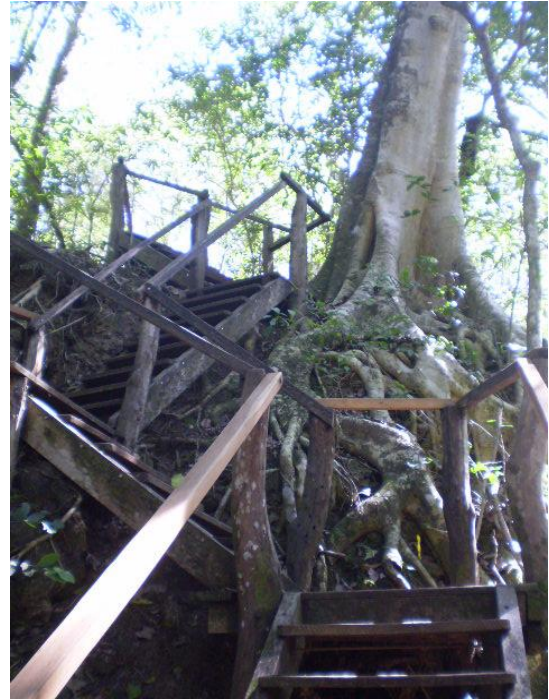
Figura 16 - Escada de baixo impacto
