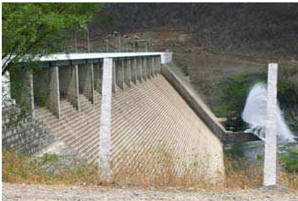
Figura 4.5 – Vista a Jusante do Reservatório Acauã
