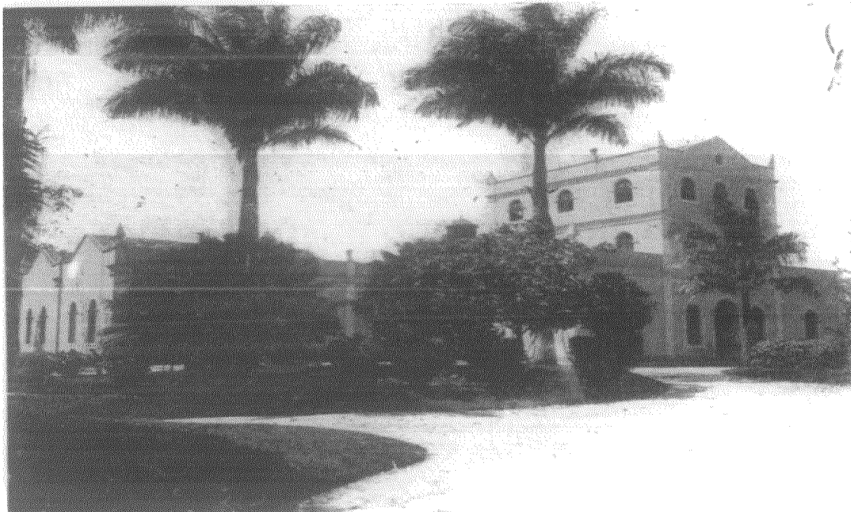
Figura 16 – Vista do prédio principal do Aprendizado Agrícola Floriano Peixoto. Fonte: BRASIL-RMA, 1939, p. 120.
