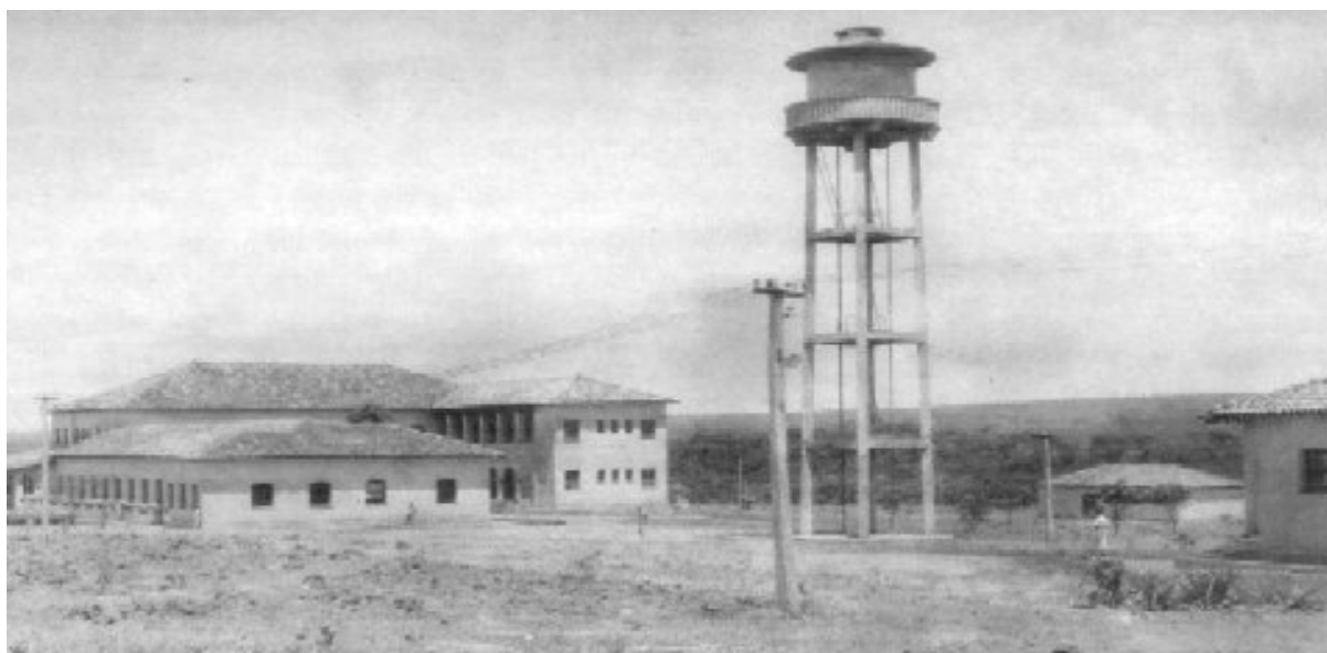
Figura 21 – Vista do prédio principal do AA Gustavo Dutra. Ano 1947. Fonte: MARQUES, 2005, p. 49.
