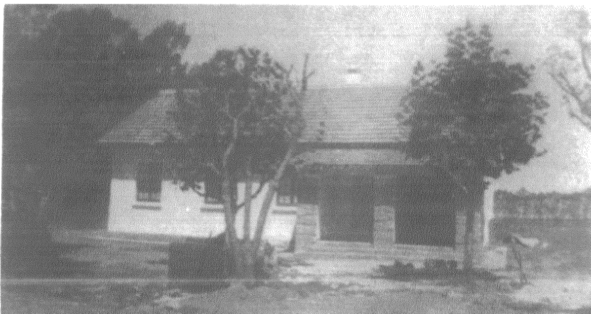
Figura 20 – Vista da residência do diretor do AA Visconde da Graça construída em 1942. Ano: 1945. Fonte: BRASIL-RMA, 1945, p. s/n.
