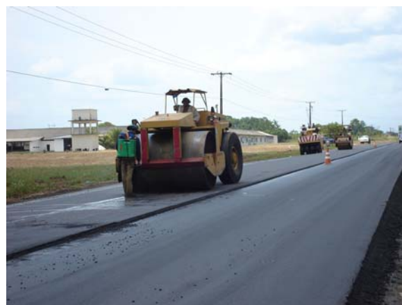
(d) Compactação da mistura asfáltica.
