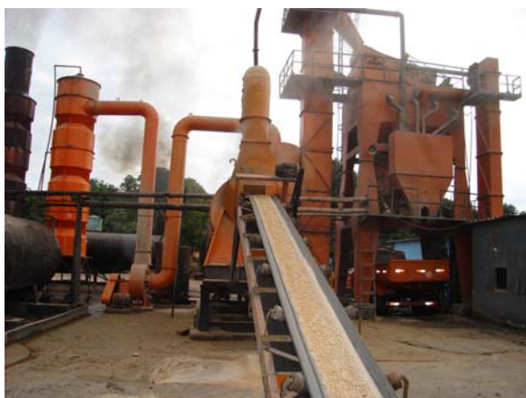
(c) Correia transportadora de agregados para alimentação do secador.
