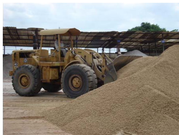
(b) Utilização de carregadeira para alimentação dos silos frios.
