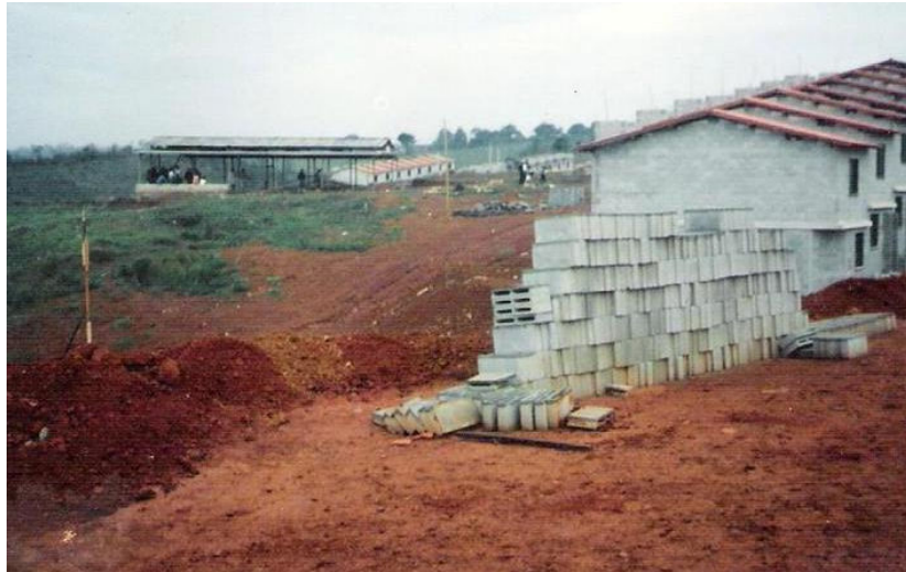
O Galpão da Cultura em construção ao fundo. A vista dá para o vale, uma área verde com mananciais: o “quintal” do bairro. Foto: Wilton Amorim.
