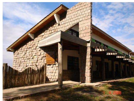
Figura 10: Fachada Leste (Bloco 1) da Escola Frei Pacífico
