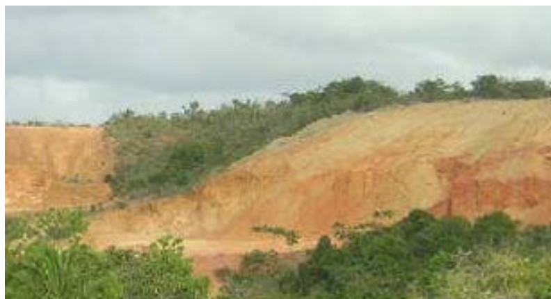
Figura 3. 3 – Foto do talude de coleta do solo JAB.
