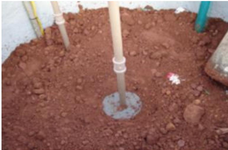
Figura 14: Placas para medição de recalque.
