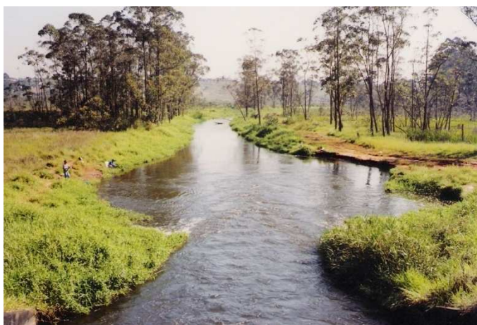
Foto II – Canal de interligação entre o reservatório de Jundiaí e o reservatório de Taiacupeba.
