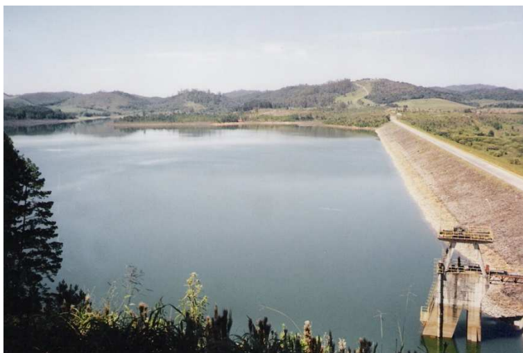
Foto VI – Barragem de Ponte Nova.
