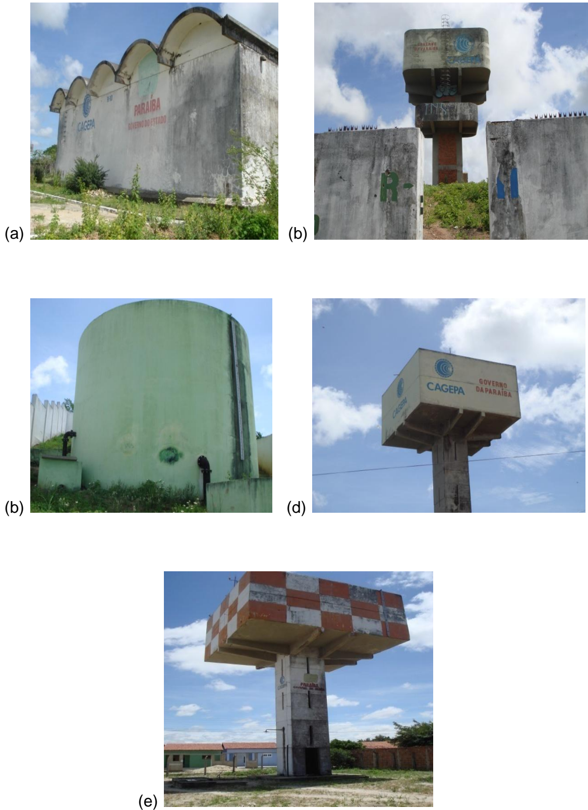
Figura 7 - Reservatórios R-10 (a), R-11 (b), R12 (c), R-13 (d) e R-14 (e) da Zona de Pressão D do sistema de abastecimento de Campina Grande
