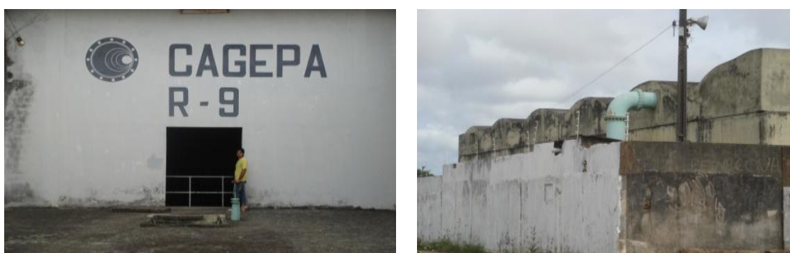
Figura 4 - Reservatório de distribuição de água R-9
