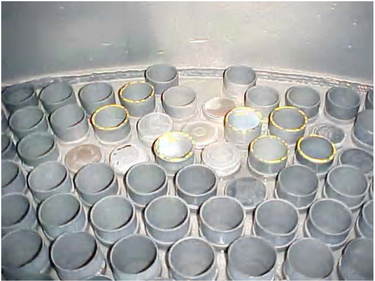
Figura 2.11 – Detalhe da luva de reforço instalada para dar maior resistência à região crítica do tubo.
