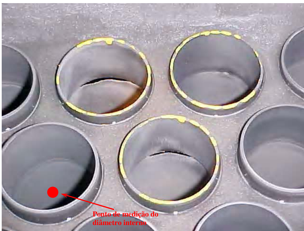
Figura 4.7 – Detalhe da extremidade superior dos tubos dos trocadores. O ponto em destaque mostra onde foram feitas as verificações do diâmetro interno como forma de medir indiretamente a espessura remanescente.
