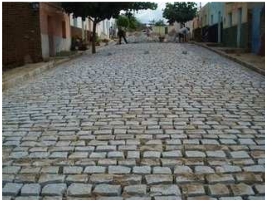
Figura 2.4 – Execução do pavimento semi-rígido.
