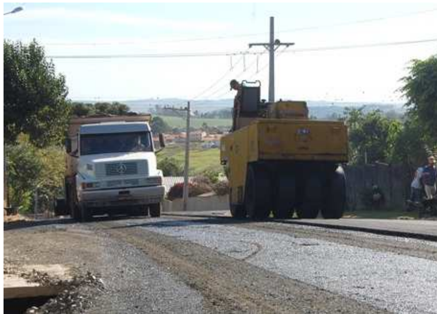
Figura 2.2 – Execução do pavimento flexível.
