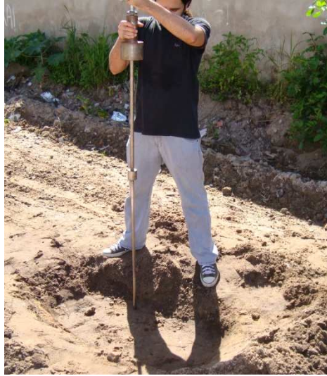
Figura 3.15 – Execução do ensaio de CPD.
