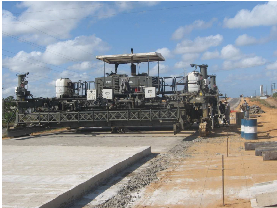
Figura 2.6 – Execução do pavimento rígido (visita BR 101, 2008).
