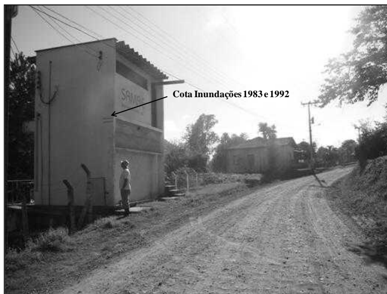
Figura 5.5 – Marca das inundações de 1983 e 1992.
