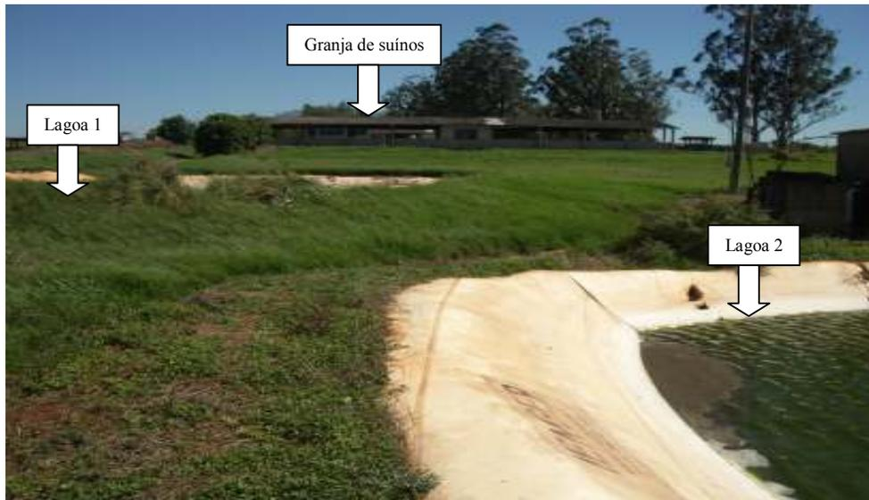
**FIGURA 6** – Visão da granja de suínos do IFET Uberaba e das duas lagoas de estabilização não sequenciais.
