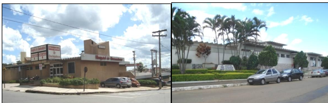
Fotos 62 e 63 – Anápolis/GO : Hospital de Queimaduras e Hospital Espírita de Psiquiatria, unidades de atendimento especializado, 2008
