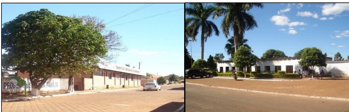
Fotos 35 e 36 - Heitorai/GO : Hospital Municipal e instalações da prefeitura da cidade, 2007
