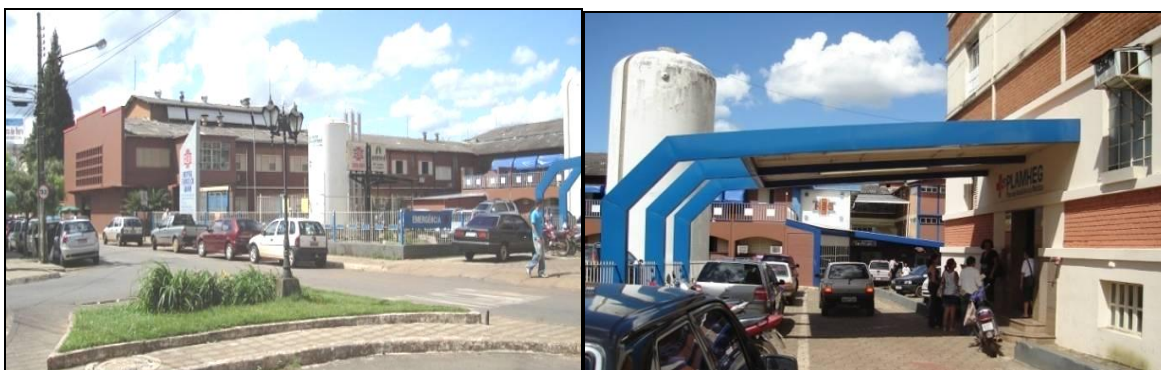
Fotos 60 e 61 – Anápolis/GO : Hospital Evangélico Goiano, especializado no atendimento de alta e média complexidade, fachada principal e entrada do pronto socorro, 2008
