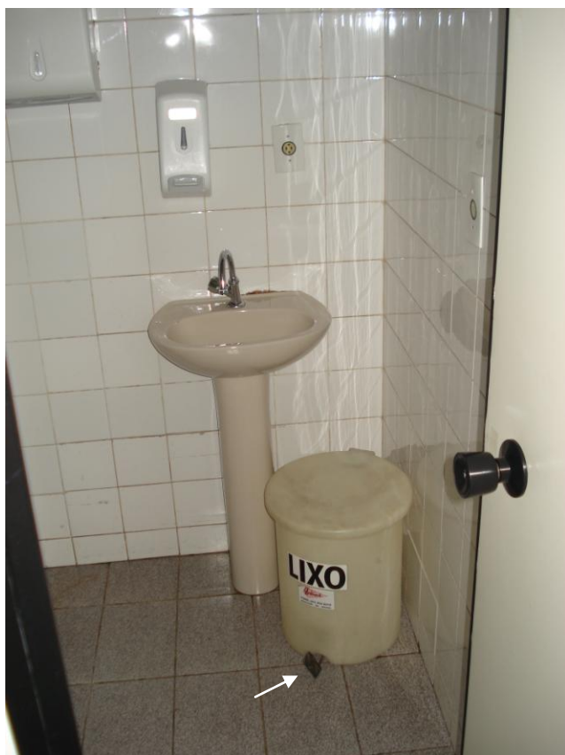
Foto 9 – Lixeira com acionamento de pedal danificado (H2)
