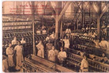
5 - La fabrique "Penedense" (Métiers à tisser de coton). Fabrica "Penedense" (Teares). Die Fabrik "Penedense" (Webstühle f. Baumwolle). (2 ex.) foto: anônima EOB: s.d./s.post./s.env. | APA: s.d./s.post./s.env.
