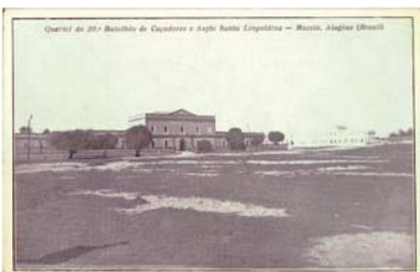
13 - Quartel do 20. Batalhão de Caçadores e Asylo Santa Leopoldina (3 ex.) foto: anônima IMS: s.d./s.inf./s.inf. | APA: s.d./s.post./s.env. JBO: s.d./s.post./s.env.
