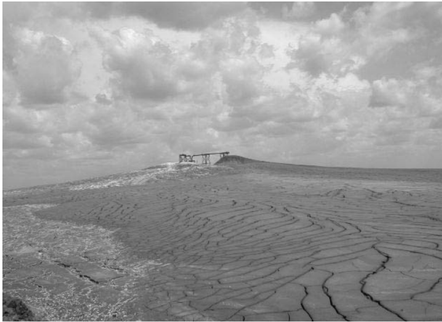
Figura 3.31: Disposição superficial de pasta na usina Bulyanhulu. (Theron et al., 2005)
