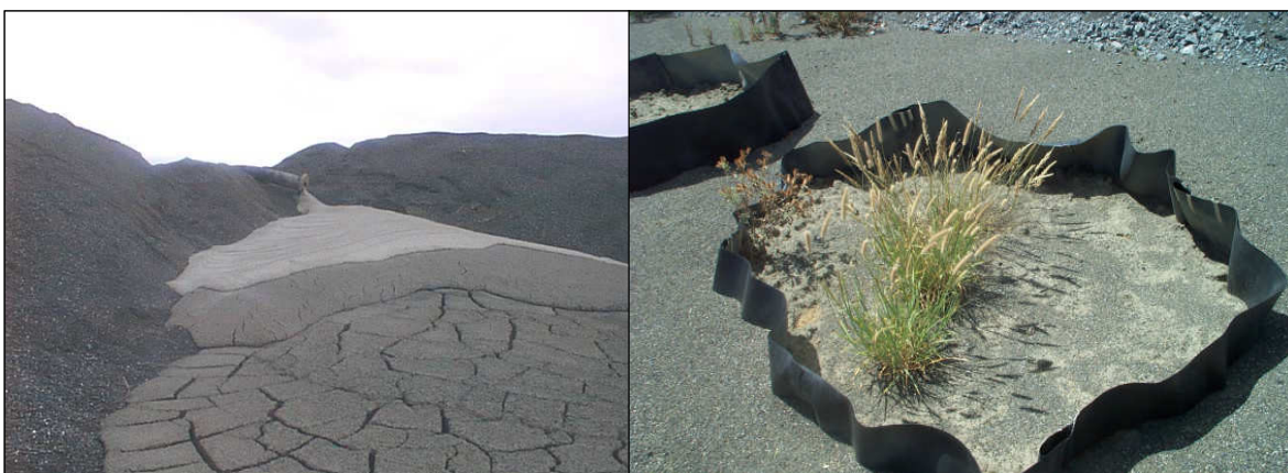
Figura 3.15: Estágios finais da co-disposição: a) disposição; b) reabilitação. (Vietti e Dunn, 2002)
