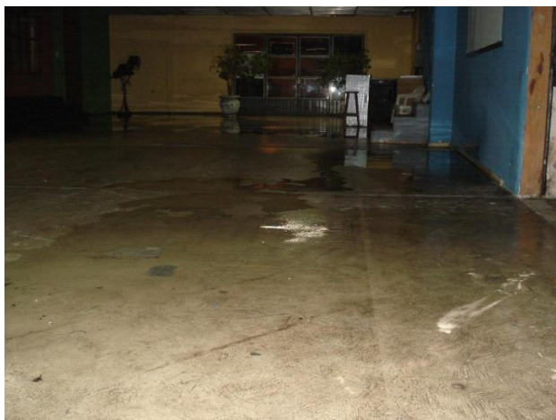
Figura 8 - Entrada principal do prédio do Cenotécnico do RS - 2009 (sob gestão do IEACEN).
