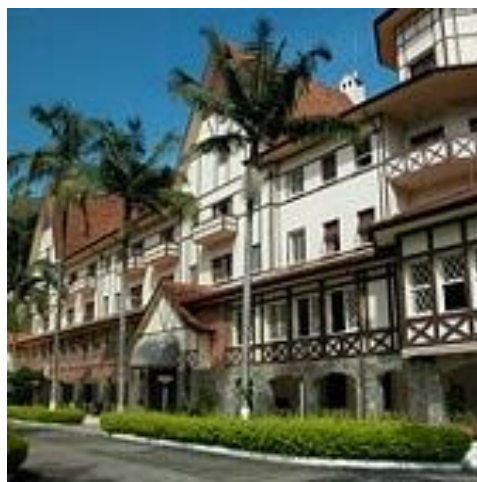
FIGURA 13 – FACHADA DO GRANDE HOTEL EM ÁGUAS DE LINDÓIA
