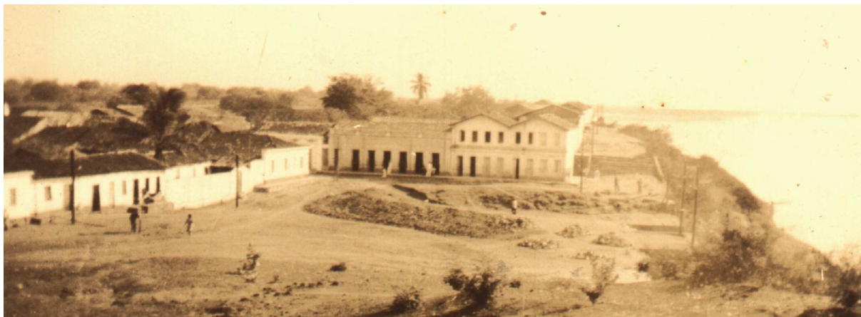
Figura 9: Construção do cais (fins da década de 1940)
