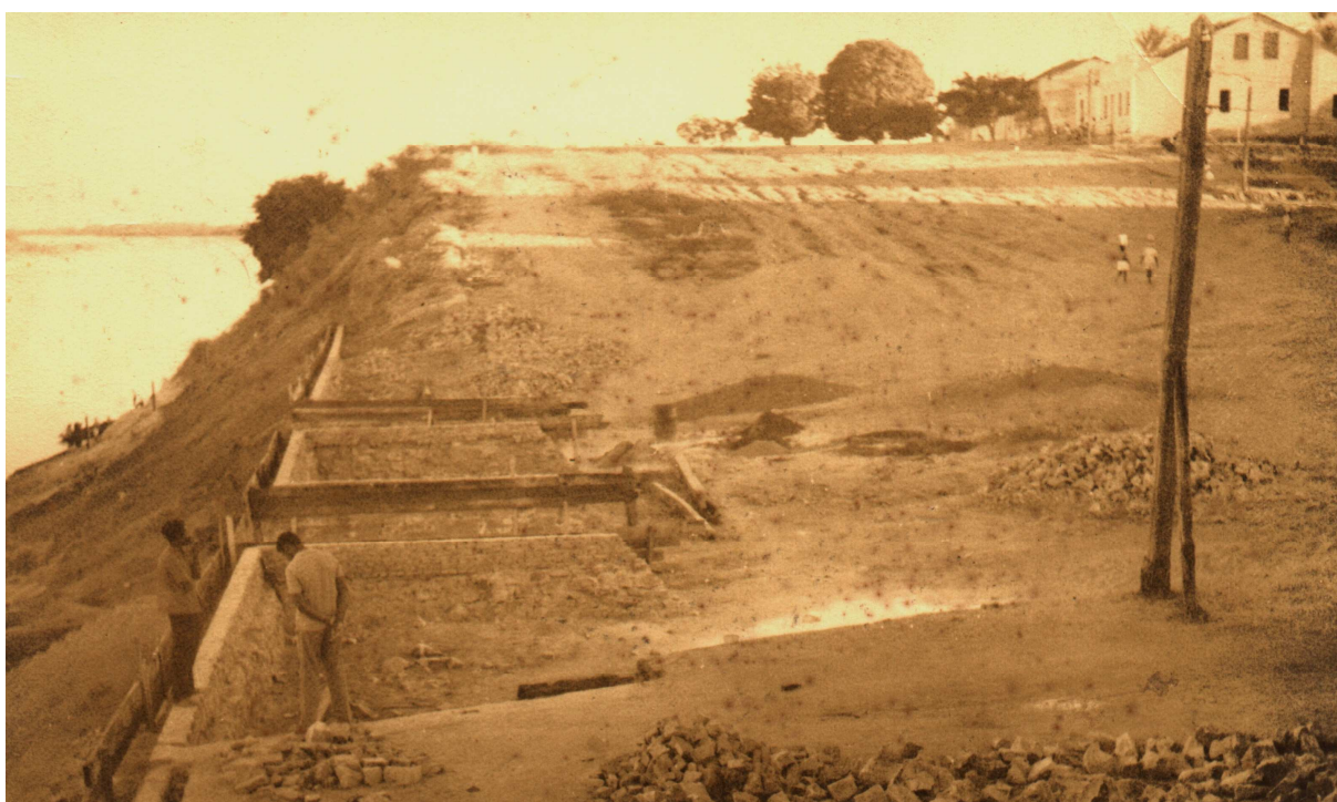
Figura 30: Construção do cais (2) Fonte: Domínio público
