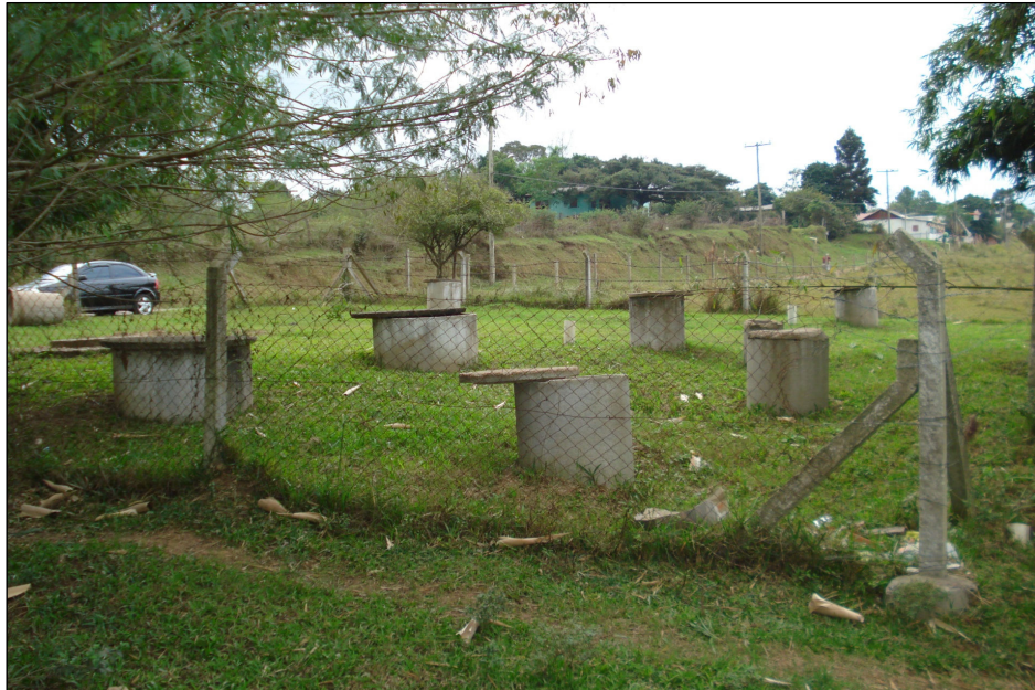
Figura 10 - Estação de tratamento de esgoto – ETE no Município de Araricá
