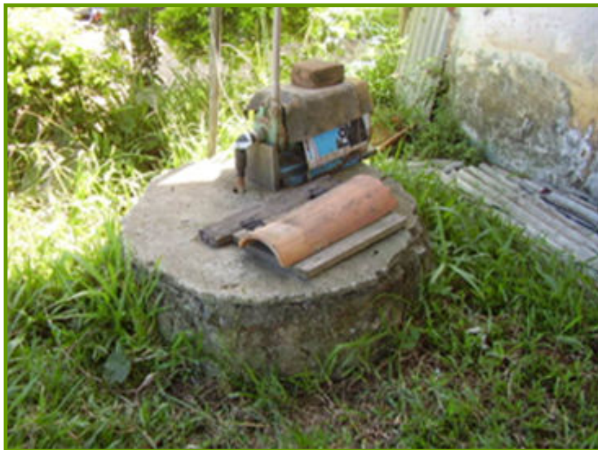
Figura 09 - Poço perfurado (profundo).
