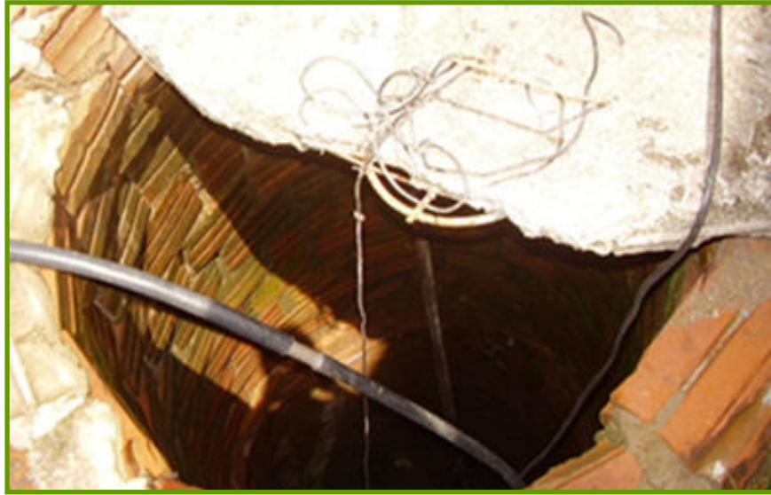
Figura 08 - Poço escavado (raso).
