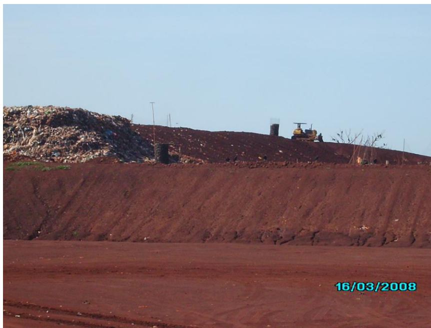
Figura 1: Local onde a terra está sendo retirada, e também a célula onde os resíduos da cidade estão sendo depositados.
