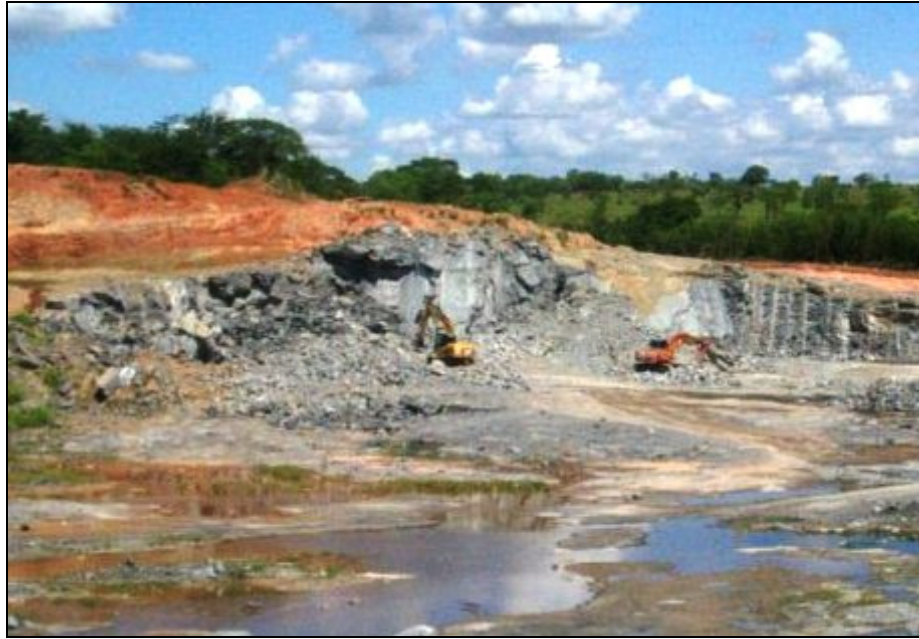
Figura 2.4 – Preparação com pás carregadeiras para carregamento dos blocos.
