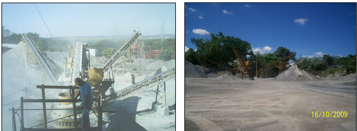
Figura 6.3 – Vista do Britador em funcionamento
