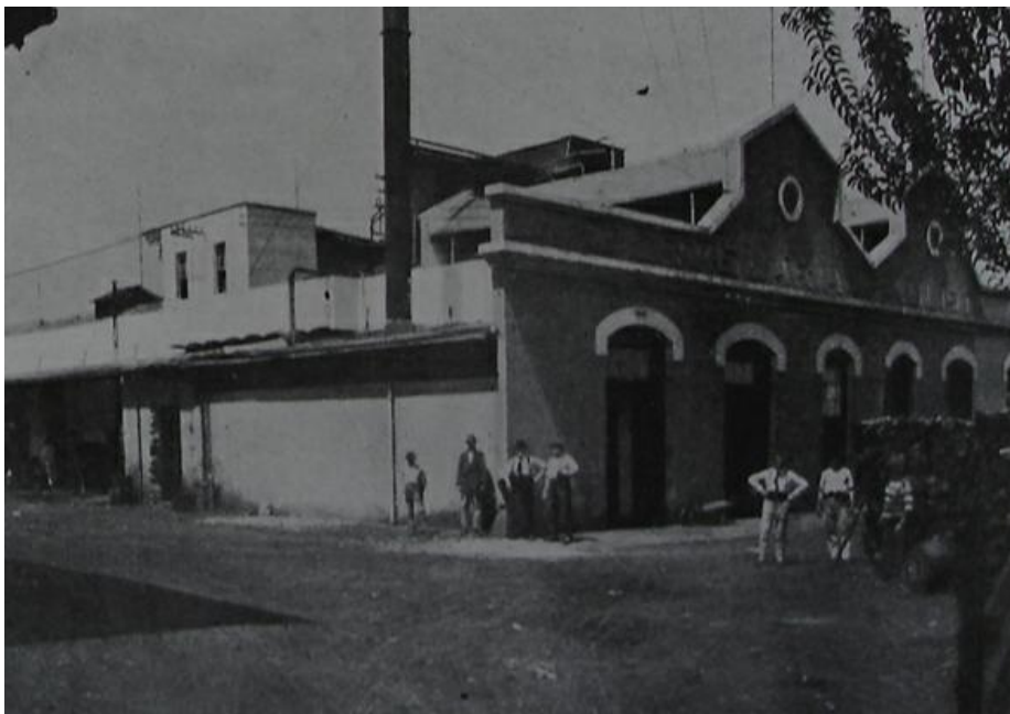
FIGURA 2: Um aspecto do prédio da Companhia Cervejaria Paulista, fundada em 1913, considerada um dos maiores expoentes do progresso industrial de Ribeirão Preto. Fonte: Revista “São Paulo, a capital artística na Comemoração do Centenário”- APHMRP.
