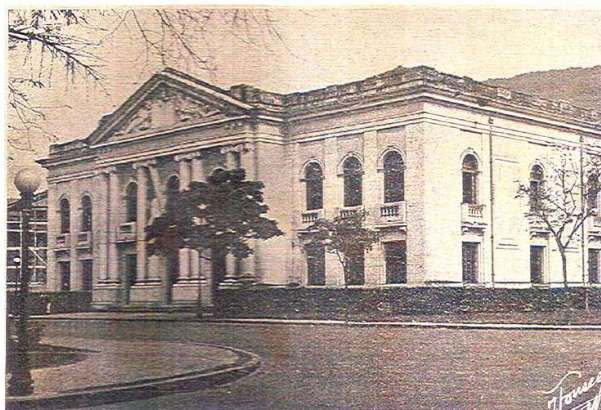
← Figura 26: Biblioteca Pública de Niterói. O salão nobre do prédio é a sede da Academia Fluminense de Letras. Niterói, s/d.
