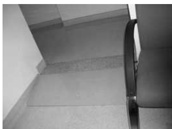
Foto 4.01 - Rampa no desnível da viga invertida. Figura 4.16 - Vigas invertidas no piso do primeiro pavimento.
