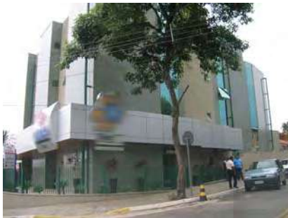
Foto 1.03 - Fachada principal CD \alpha .
