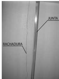
Foto 4.02 - Junta de dilatação. Foto 4.03 - Rachadura no segundo pavimento. Foto 4.04 - Rachadura no térreo. Fonte: acervo da pesquisadora.
