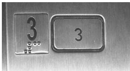
Foto 4.51 - Comando do elevador.
