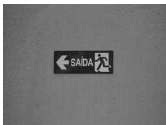
Foto 5.36 - Sinalização rota de fuga.
