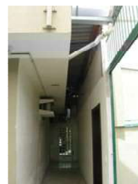
Foto 5.04 - Cobertura em telha. Fonte: acervo da pesquisadora.
