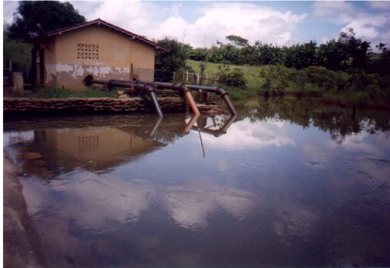
Figura1. Captação do Km 4. Fonte: trabalho de Campo, 2003.
