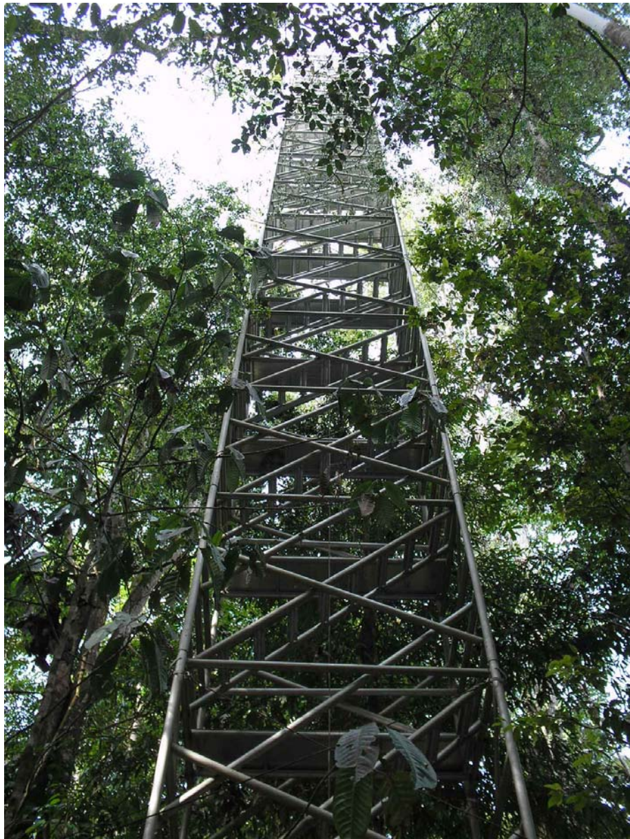
Figura 6. Vista do solo da torre metálica com 30 m de altura instalada na parcela A do experimento ESECAFLOR
