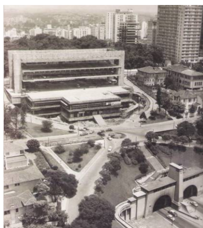
Figura 42 – Vista da construção do MASP, na década de 1960. Fonte: MASP, 2008.
