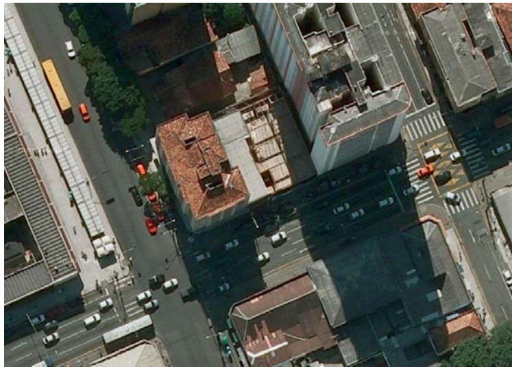
Figura 60 – Vista aérea do MAC. Fonte: www.maps.google.com.br
