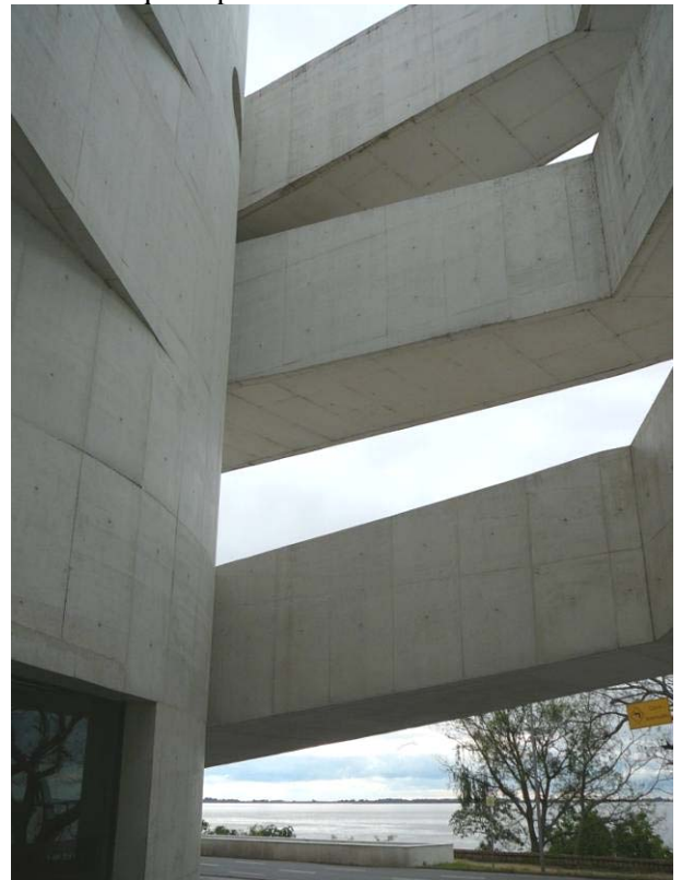
Figura 106 – Vista das rampas, a partir da entrada principal do museu. Fonte: Arquivo pessoal
