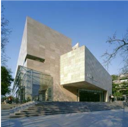
Figura 112 – Vista externa da escadaria e café do MALBA. Fonte: www.images.google.com.br .
