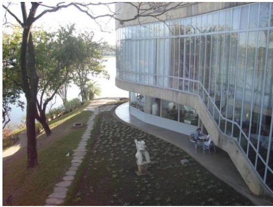
Figura 54 – Vista lateral esquerda do prédio do MAP.
