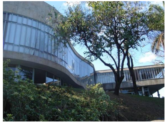
Figura 55 – Vista lateral esquerda do prédio do MAP.
