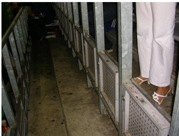
Figura 33 - Assentos retráteis da Südtribune em Dortmund.
