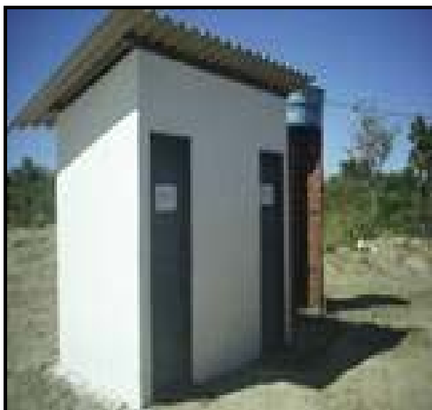
Figura 54: Foto de banheiros na praia de São Félix – TO. Fonte: Autora. Julho/2008.
