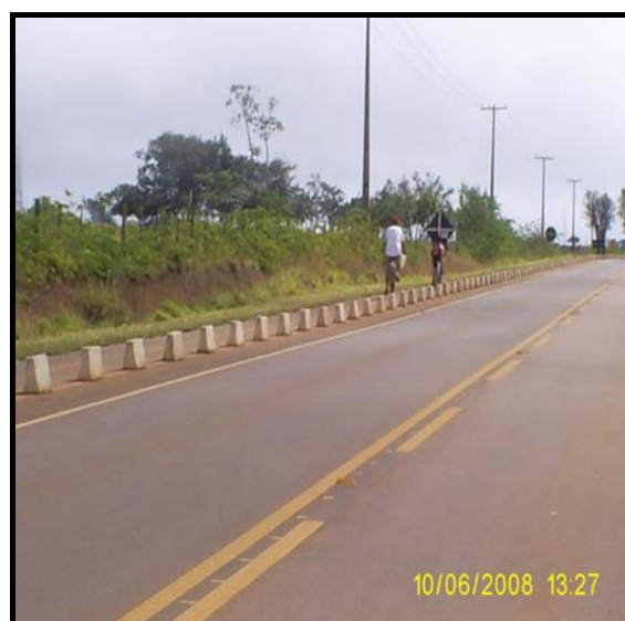
Figura 47: Foto da Ciclovia na EP – MT. Fonte: Autora, junho/2008.
