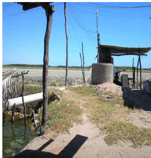
Figura 27 – Casa de bomba puxando água de um canal para abastecimento do viveiro.
