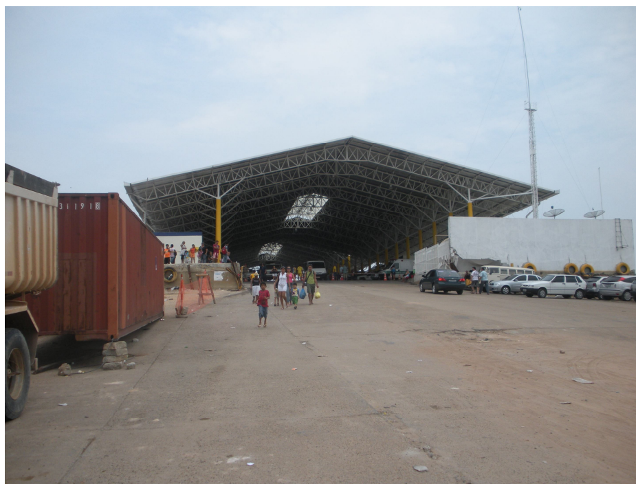
Foto 15: Porto da Ceasa depois da construção do galpão.
