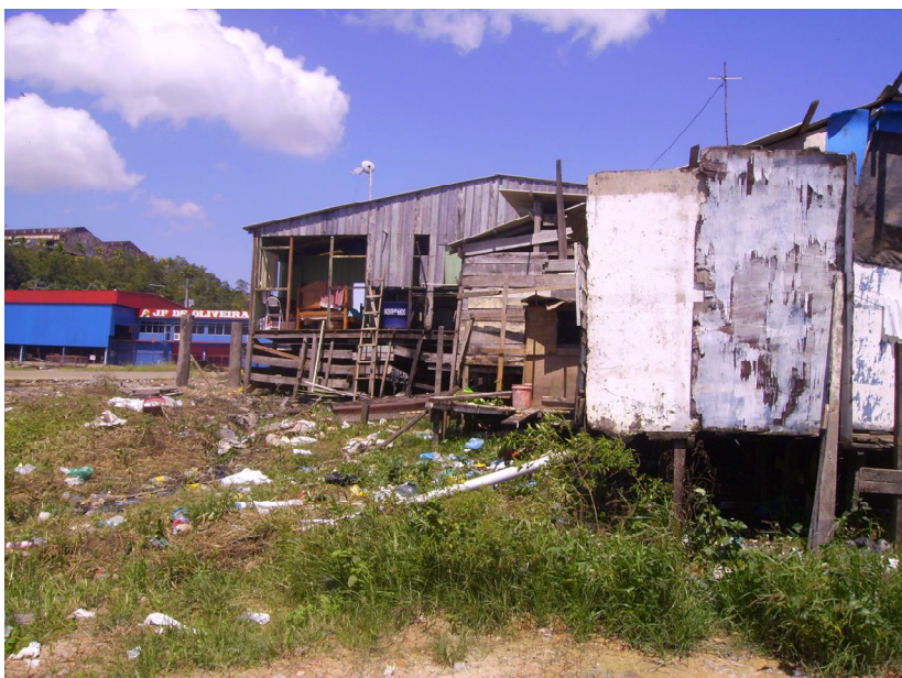
Foto 25: Fundo dos boxes improvisados antes da construção da cobertura.
