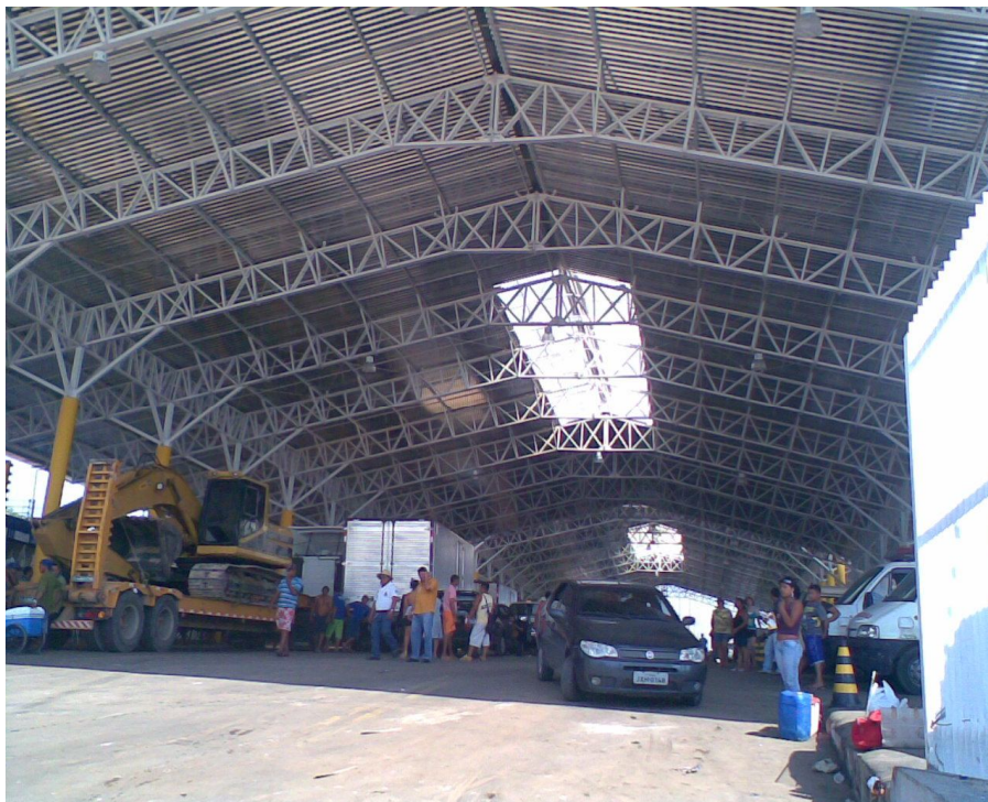
Foto 39: Galpão do porto da Ceasa.
