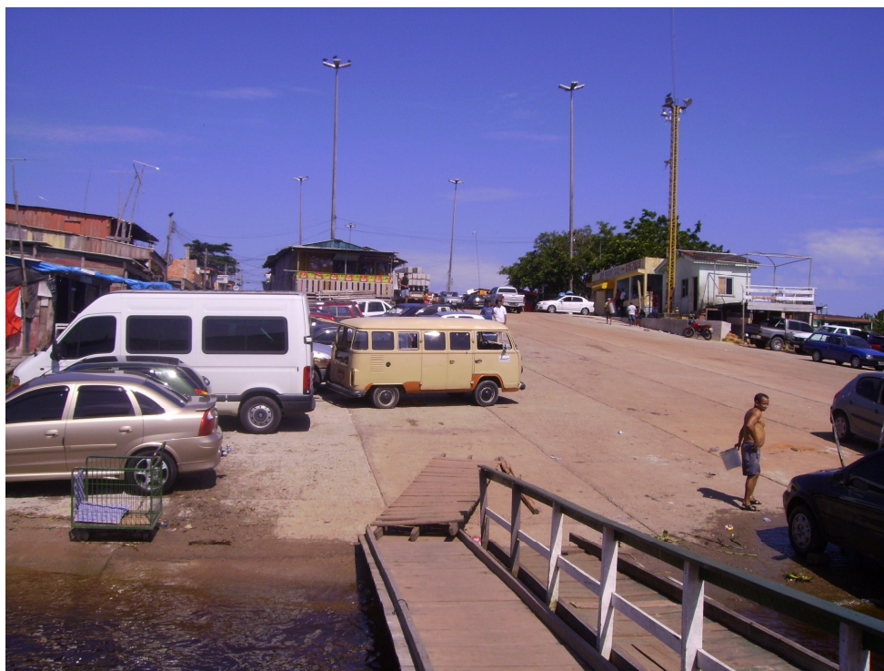
Foto 14: Porta da Ceasa antes da construção da cobertura.
