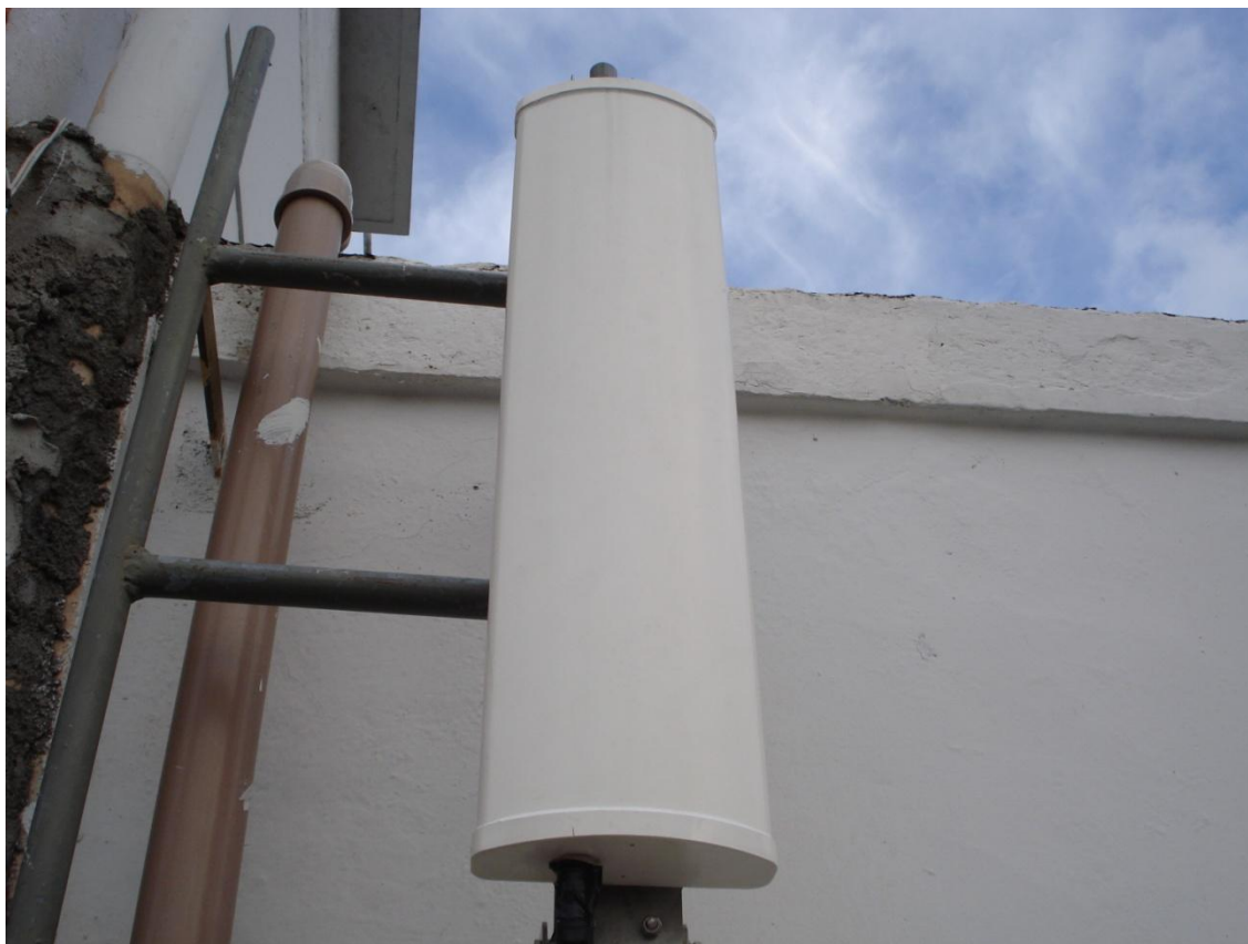
Figura 5.7 – Antena transmissora Hyperlink HG3515P-120
