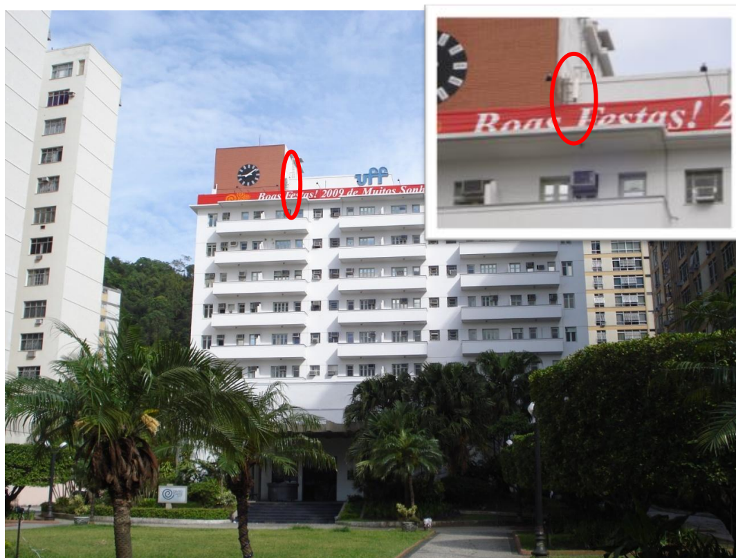
Figura 5.17 – Visão frontal do prédio da Reitoria da UFF, com foco na antena transmissora
