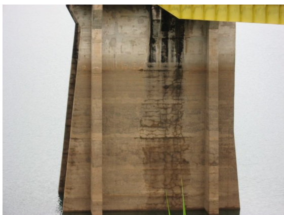
Figura 30: Fissurações aleatórias nas paredes externas e contrafortes
