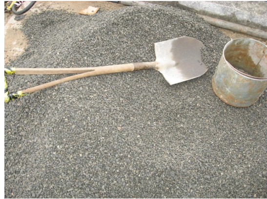
Figura 66: Pedrisco para preenchimento dos furos
