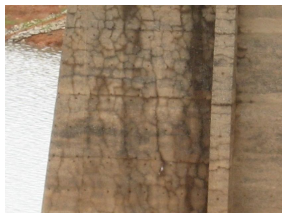
Figura 30: Fissurações aleatórias nas paredes externas e contrafortes
