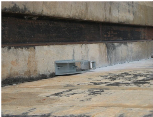
(c) Apoio da extremidade livre e cantoneira guia
