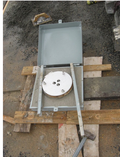
(b) Chumbamento com a caixa de proteção
