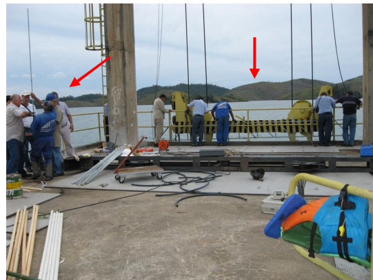
(f) Frentes de trabalho. Instalação das hastes dos extensômetros e dos aparatos de medição
