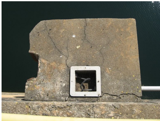
(a) Vista superior (muro guia esquerdo)
