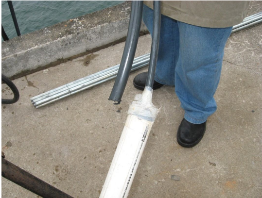
Figura 65: Borracha de Polietileno danificada
