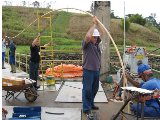
(b) Tubo de PVC sendo colocado no furo
