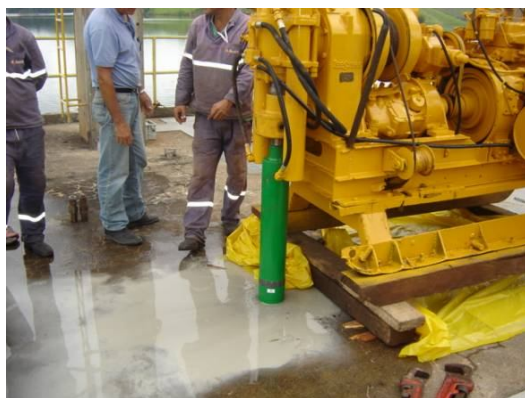
(a) Perfuratriz iniciando o furo
