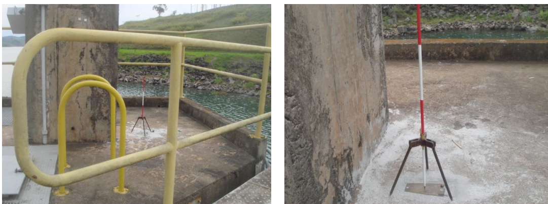
Figura 43: Baliza centrada em MS na laje da tomada d'água
