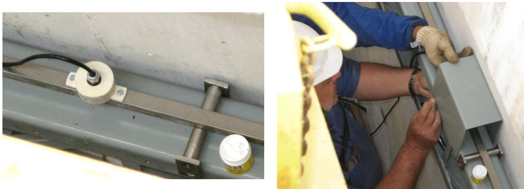
Figura 93: Termômetro instalado na barra de invar
