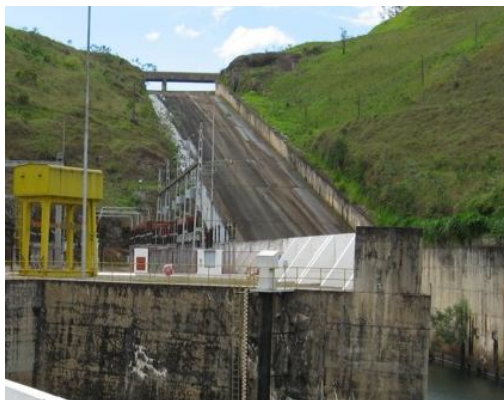
Figura 18: Vertedouro de superfície
