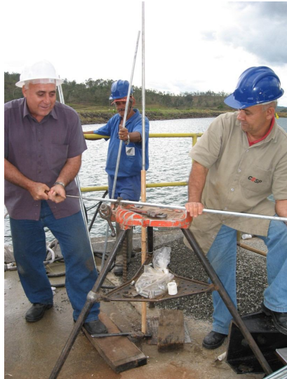
(a) Colocação das hastes no tubo
