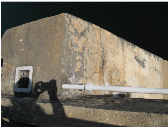
(c) Vista lateral esquerda (muro guia esquerdo)
