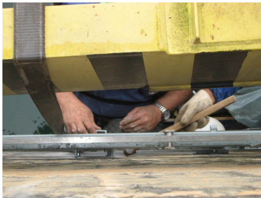
(e) Posicionamento da barra de invar na viga
