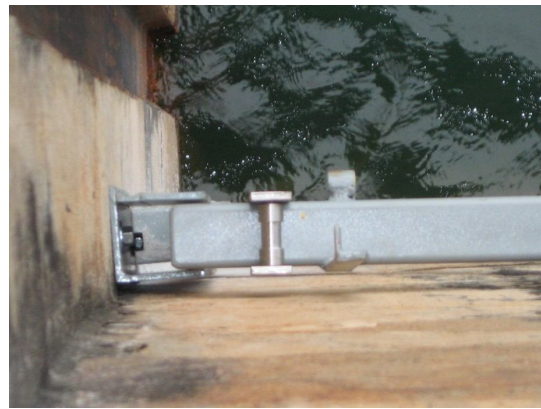
(d) Viga metálica posicionada
