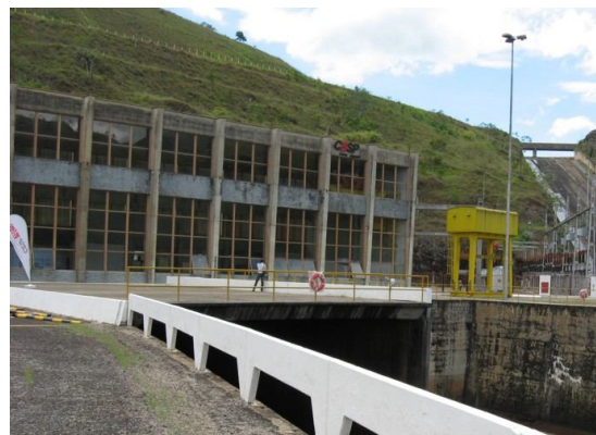
Figura 19: Casa de força
