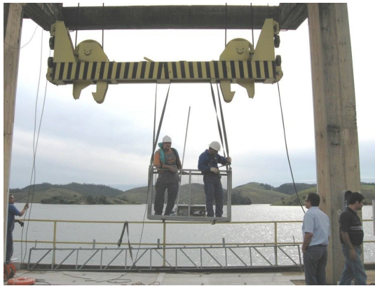
(a) Ponte rolante com andaime suspenso
