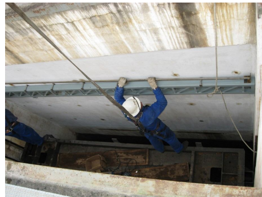
(b) Posicionamento da viga e barra de invar
