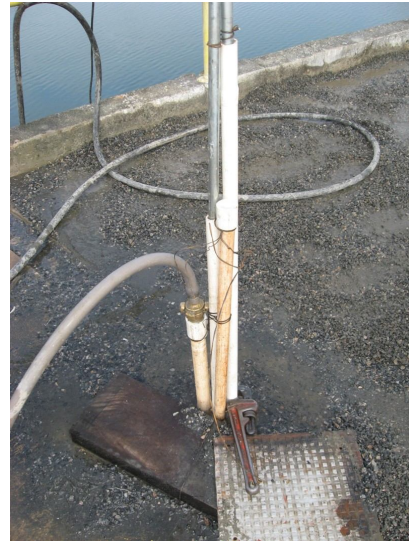
(b) Aplicação de graute para chumbamento
