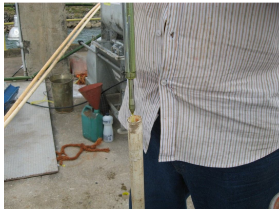
(d) Pino guia de ancoragem sendo colocado no PVC
