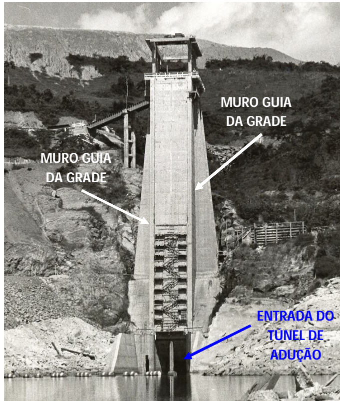
Figura 20: Tomada d'água em construção. Vista frontal
