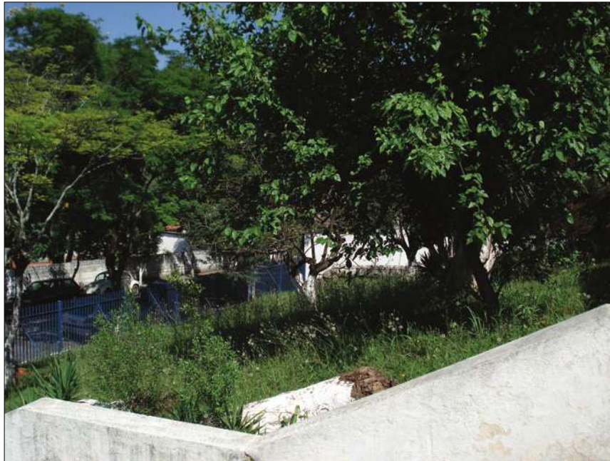
Fig. 5.5. – Recuo lateral com seu paisagismo inadequado. Fonte - Autor
