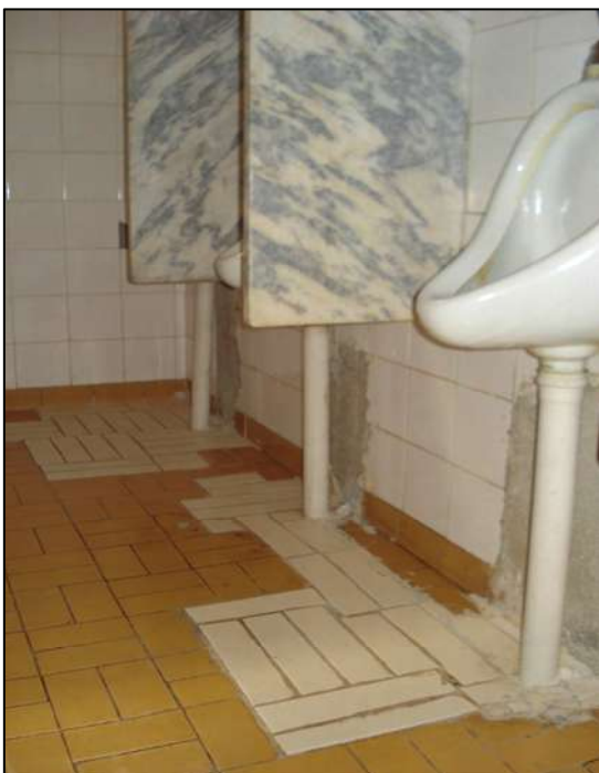
Fig. 4.46. – Adaptação da tubulação de esgoto dos mictórios Fonte – Autor
