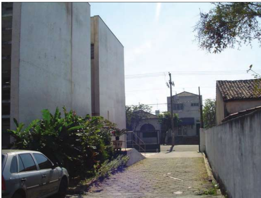
Fig. 7.15. – Piso sextavado de concreto (bloquete) – área externa Fonte – Autor
