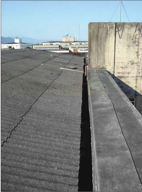
Fig. 8.10. - Vista da calha de captação de águas pluviais Fonte – Autor
