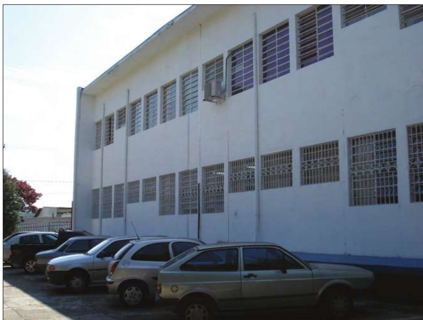
Fig. 5.11. – Fachada posterior da edificação voltada para o sudeste sem proteção Fonte – Autor
