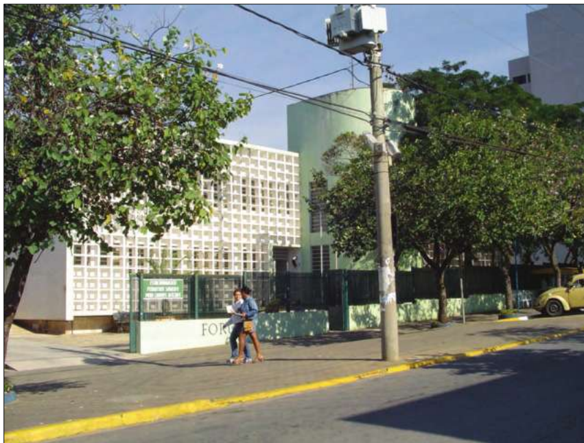
Fig. 7.6. – Fachada principal do edifício voltada para o nordeste Fonte – Autor
