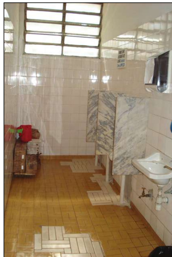
Fig. 4.36. – Reposição de cerâmicas diferentes no piso do banheiro masculino Fonte – Autor
