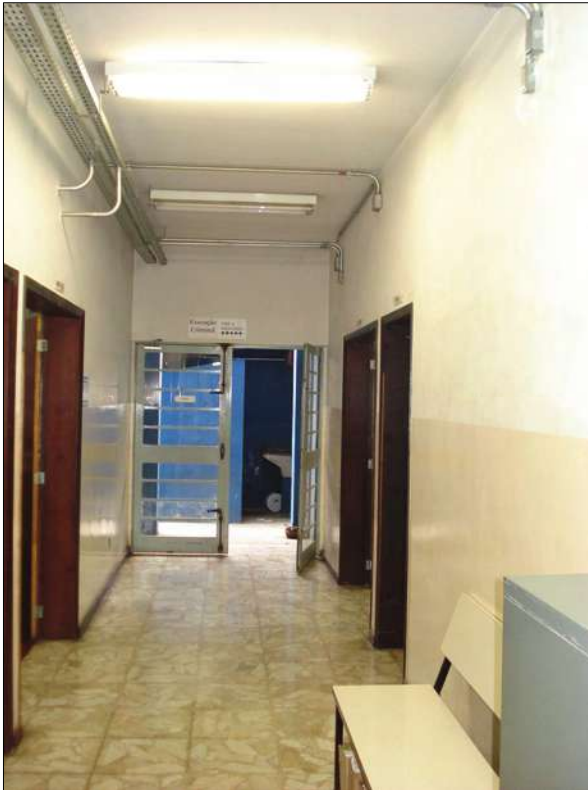
Fig. 6.24. – Corredor do pavimento térreo Fonte – Autor
