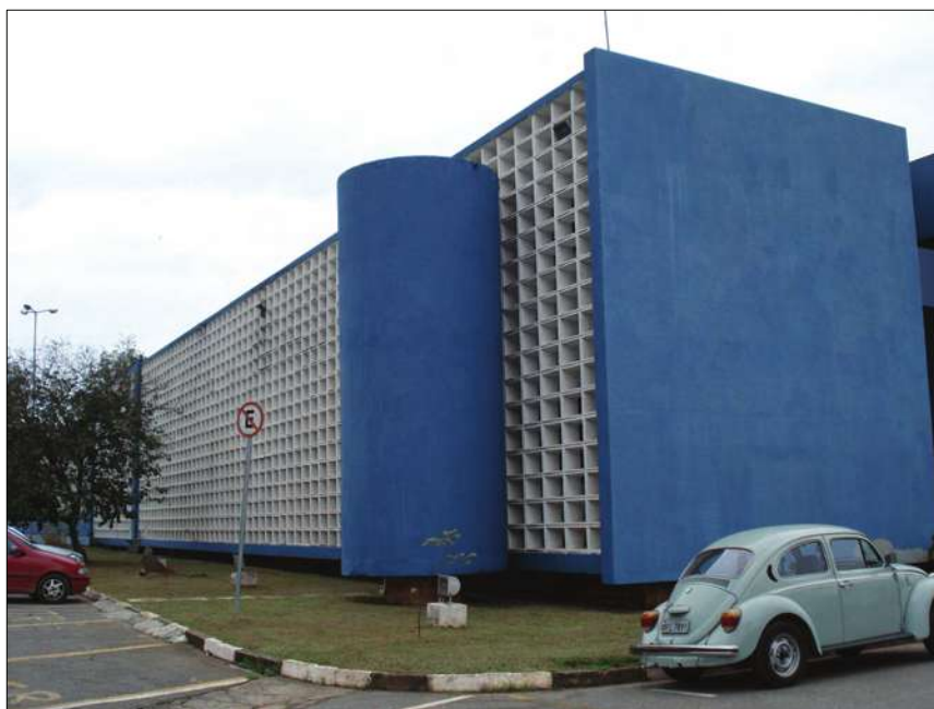
Fig. 6.8. – Fachada posterior do edifício voltada para o oeste Fonte – Autor
