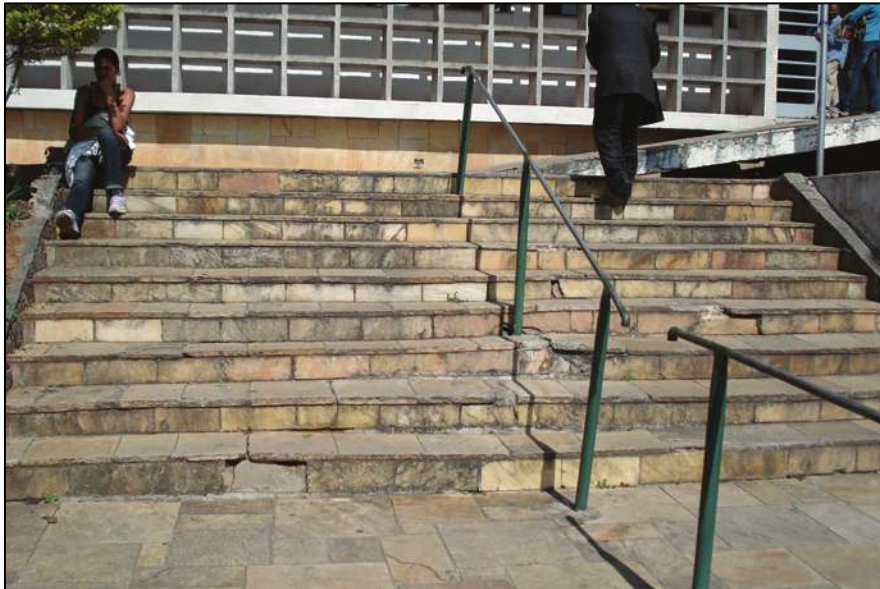
Fig. 4.29. – Escada de acesso ao edifício. Fonte – Autor
