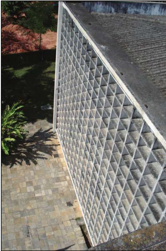
Fig. 4.23. – Elementos vazados da fachada Fonte – Autor
