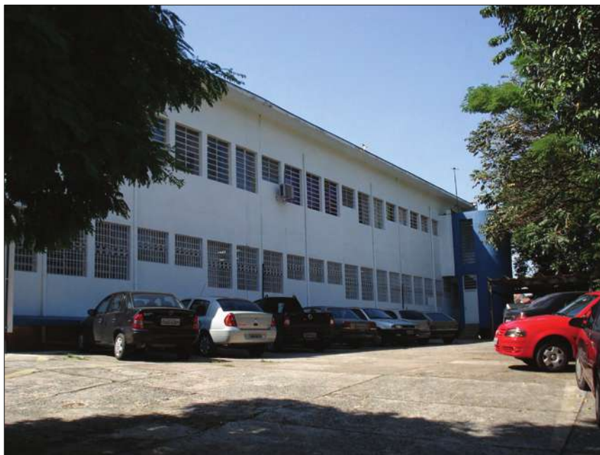
Fig. 5.8. – Fachada posterior do edifício voltada para o sudeste Fonte – Autor
