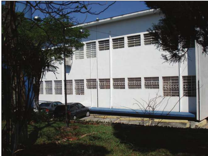
Fig. 5.10. – Fachada principal do edifício voltada para o noroeste sem proteção Fonte – Autor
