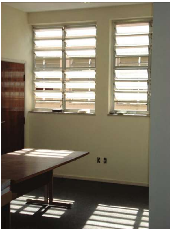
Fig. 8.20. – Caixilhos com vidros transparentes Fonte – Autor
