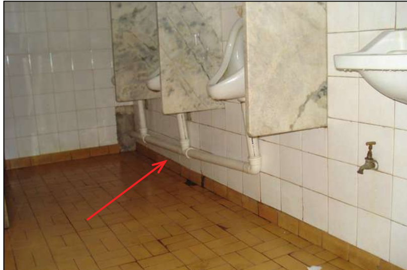
Fig. 4.48. – Adaptação da tubulação de esgoto dos mictórios Fonte – Autor
