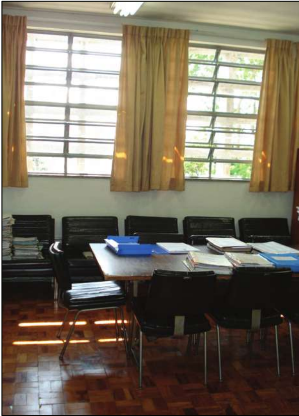
Fig. 4.18. – Caixilhos com vidros transparentes Fonte – Autor
