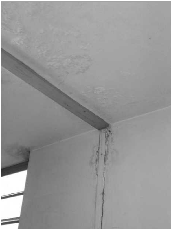
Fig. 6.15. – Laje da escada principal Fonte – Autor
