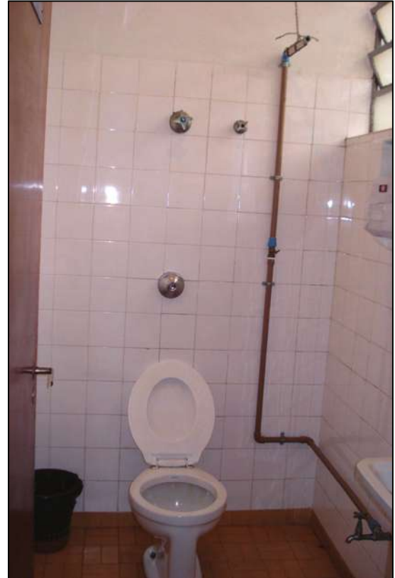
Fig. 4.45. - Detalhe de uma adaptação Fonte – Autor
