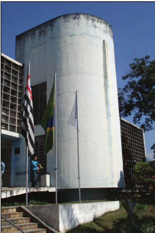
Fig. 4.21. – Caixa de escada principal Fonte – Autor
