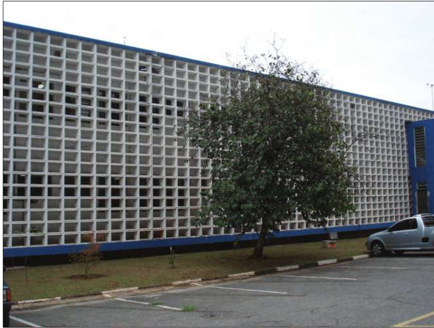
Fig. 6.17. – Fachada posterior da ampliação voltada para o nordeste sem proteção Fonte – Autor
