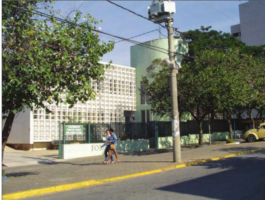
Fig. 7.11. – Fachada principal voltada para o nordeste sem proteção Fonte – Autor
