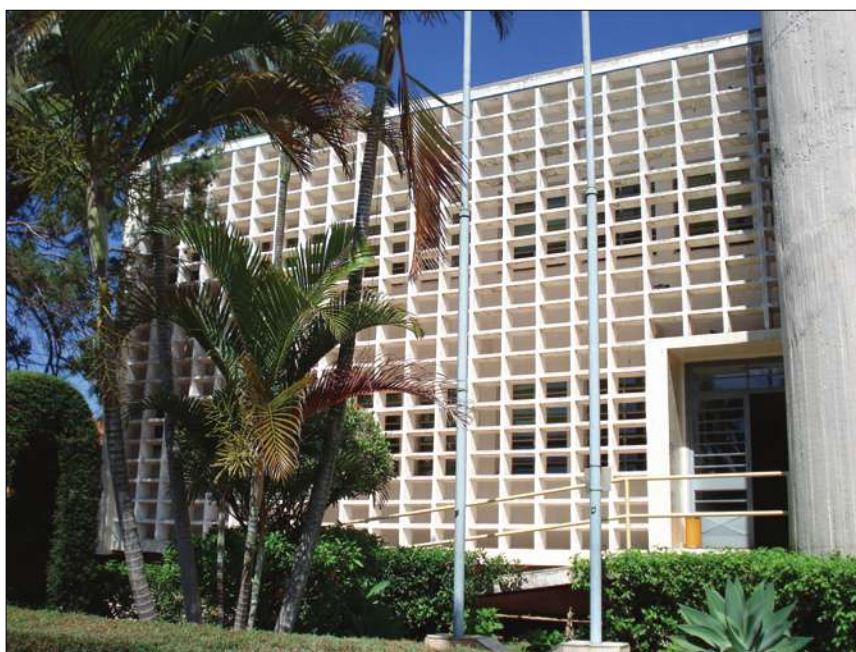
Fig. 9.13. – Fachada principal voltada para o nordeste sem proteção, com a conseqüente entrada direta de luz solar para dentro da edificação
