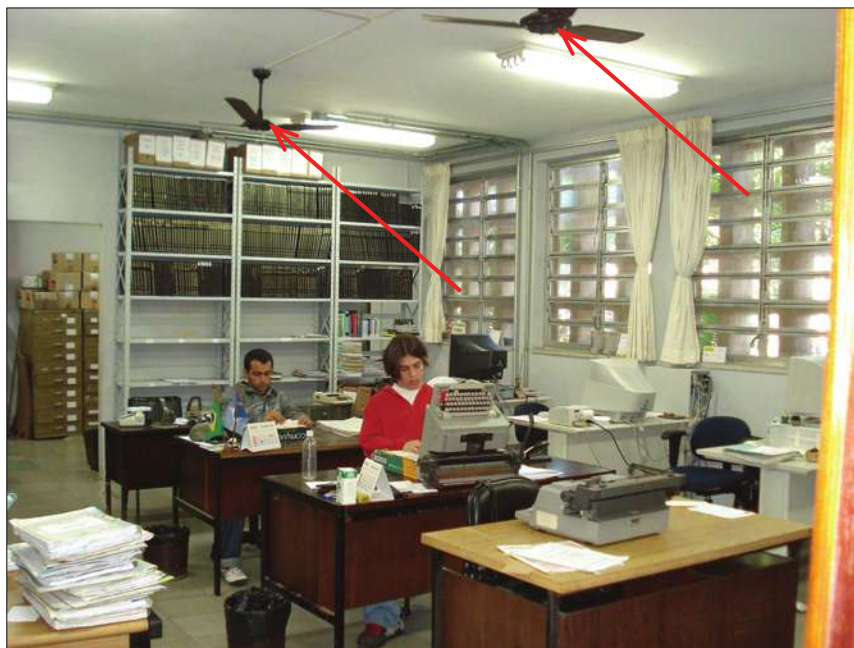
Fig. 8.33. – Ventiladores instalados no teto Fonte – Autor
