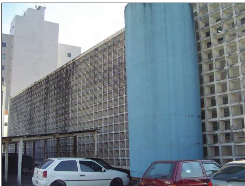
Fig. 7.14. – Elementos vazados da fachada posterior e caixa de escada Fonte – Autor
