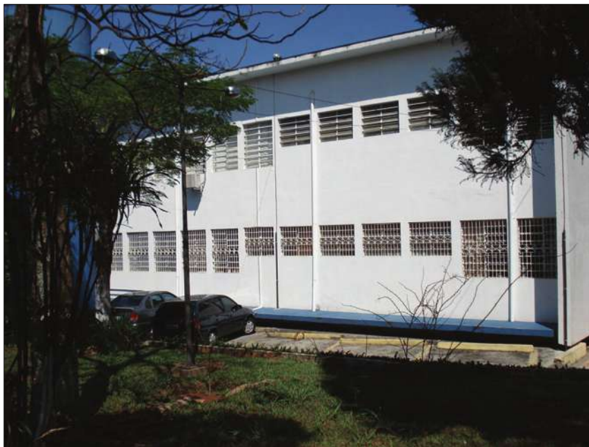
Fig. 5.7. – Fachada principal do edifício voltada para o noroeste Fonte – Autor
