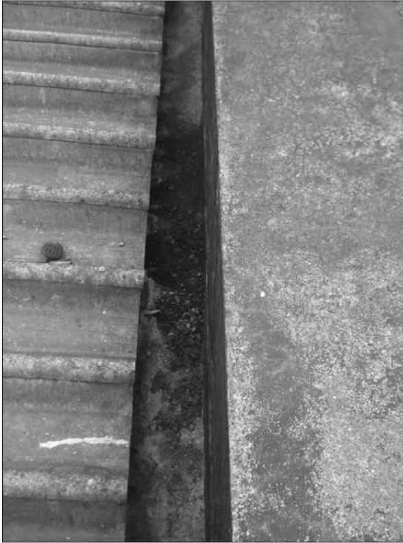
Fig. 6.9. - Vista da calha de captação de águas Fonte – Autor
