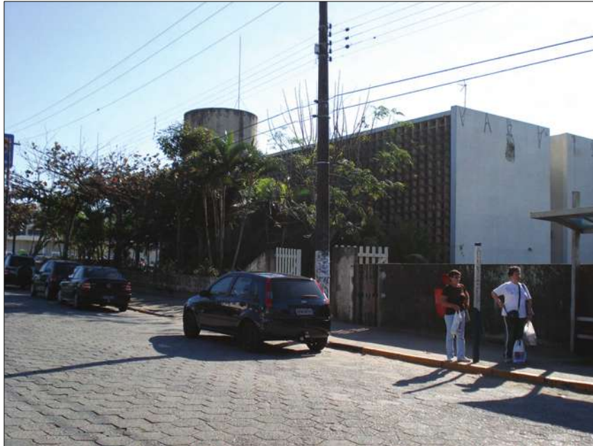
Fig. 8.7. – Fachada principal do edifício voltada para o sudeste Fonte – Autor
