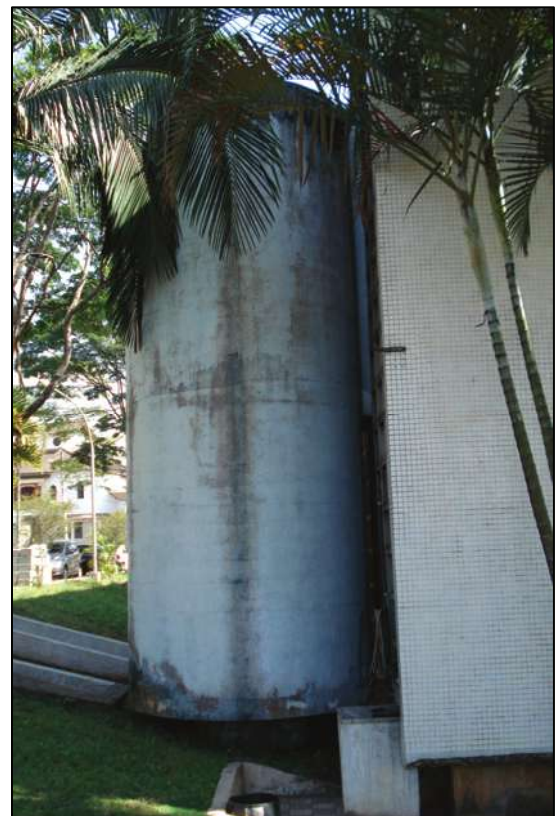
Fig. 4.22. – Caixa de escada dos presos Fonte – Autor
