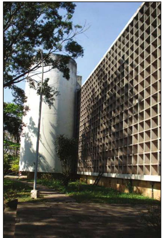
Fig. 4.24. – Elementos vazados da fachada Fonte – Autor
