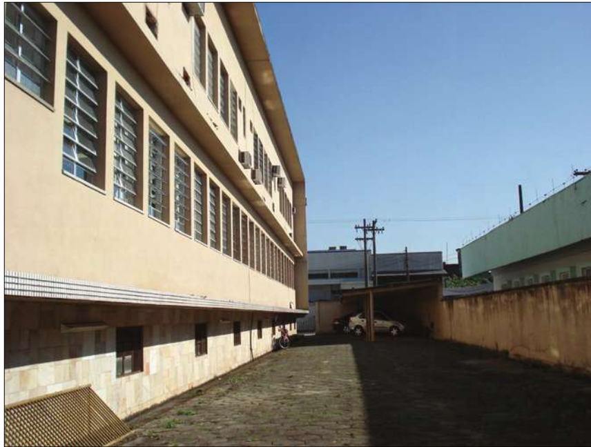
Fig. 8.16. – Fachada posterior da ampliação voltada para o nordeste sem proteção Fonte – Autor
