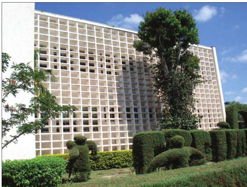
Fig. 9.7. – Fachada principal do edifício voltada para o nordeste Fonte – Autor
