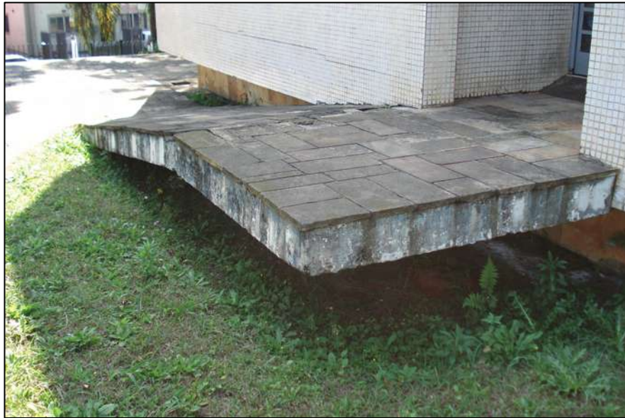
Fig. 4.31. – Detalhe da rampa lateral de acesso ao edifício. Fonte – Autor
