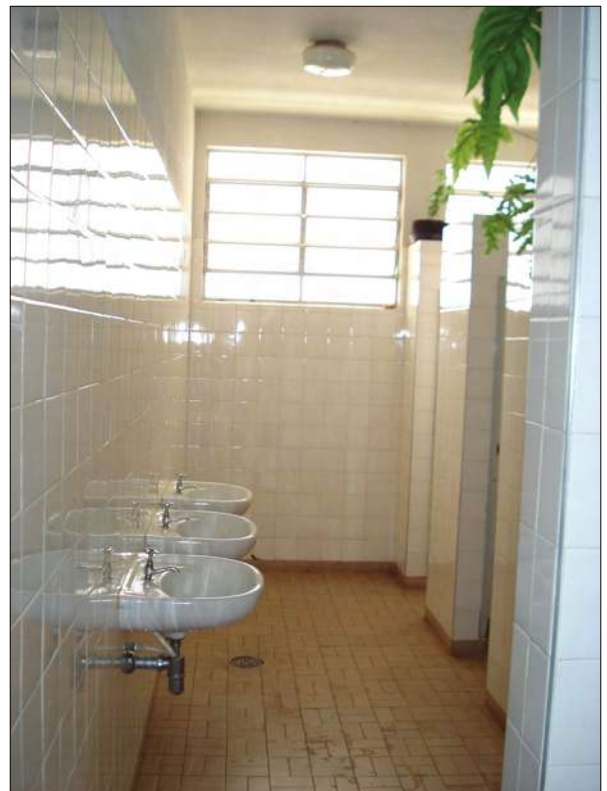
Fig. 9.20. – Sanitário feminino (piso cerâmico) Fonte – Autor
