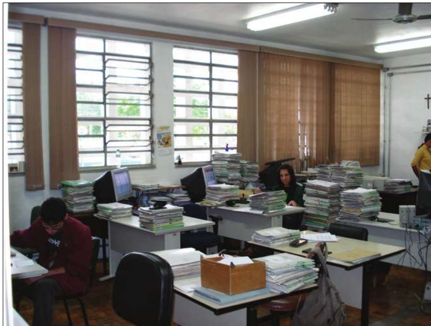
Fig. 6.22. – Caixilhos com vidros transparentes Fonte – Autor
