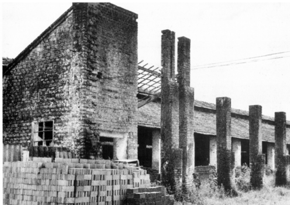
Figura 18: Ruínas da Cerâmica São João, 1971. (Fonte: Catálogo Brennand – Esculturas 1974/1998)
