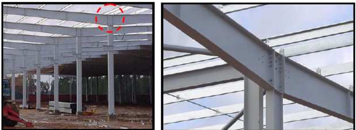
Figura 1.3 – Ligação de um pórtico de galpões com vigas inclinadas
