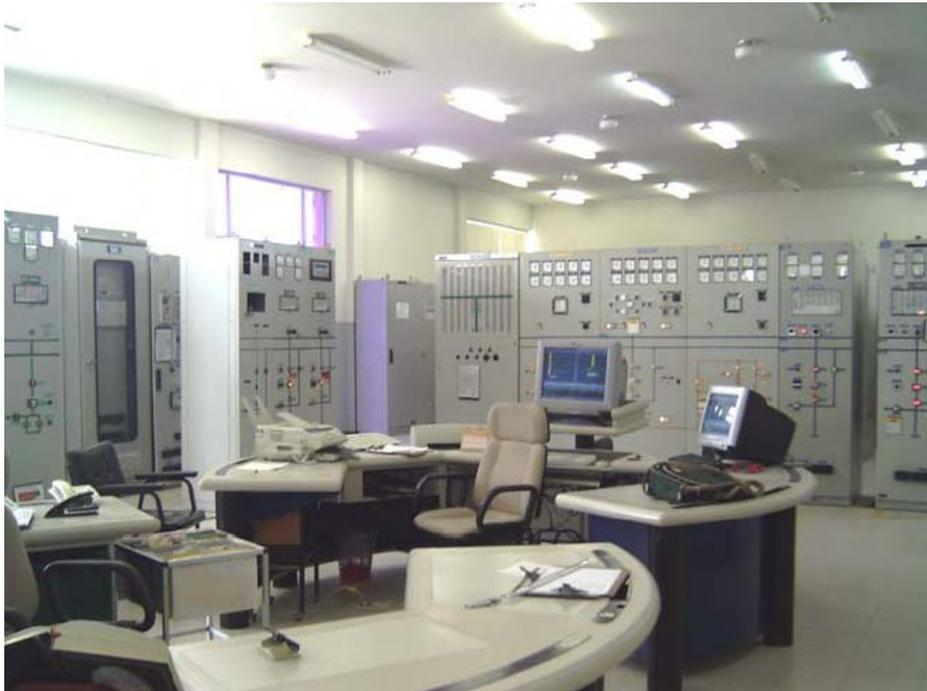
Figura 10: Sala de comando de subestação
