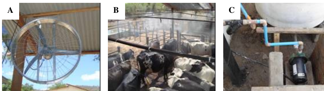
Figura 11 – Ventilador utilizado no SRAE* (A); detalhe da linha de nebulização (B); bomba d'água utilizada no SRAE* (C).
