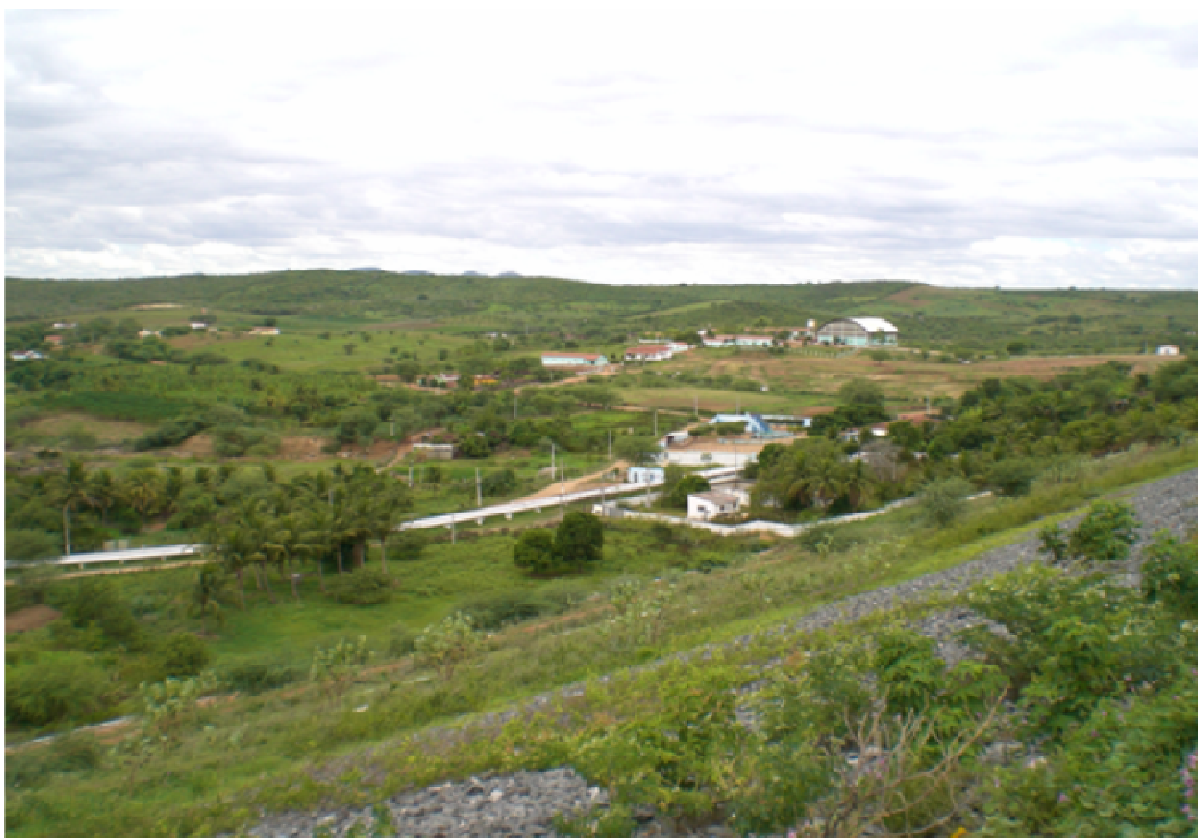
Foto 18 - A Adutora (2 tubulações) Fonte: Dados da pesquisa.
