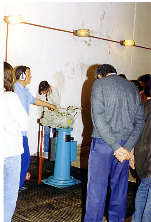
Figura 15 – Vista parcial da Casa das Máquinas. Ao fundo, operador de máquinas demonstra o funcionamento do registro.
