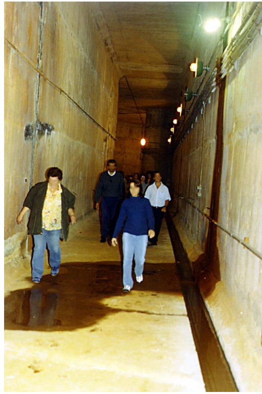
Figura 13 – Vista parcial do túnel sob a barragem do rio Cachoeira.
