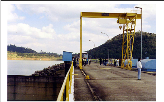
Figura 10 – Barragem e vista parcial da represa do rio Cachoeira.
