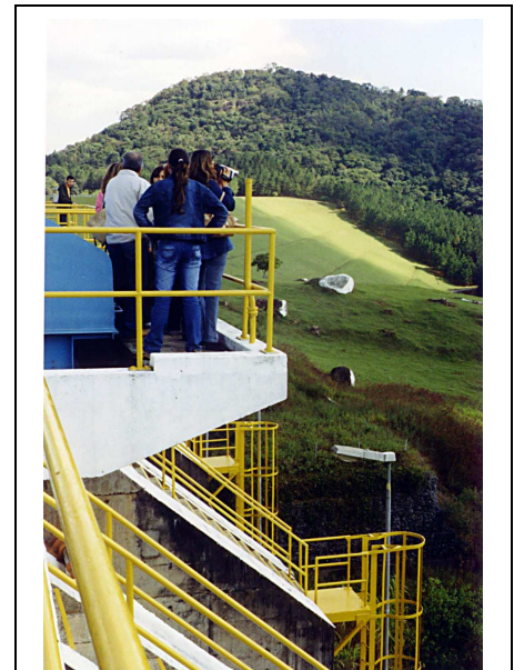
Figura 11 – Vista parcial do vertedouro da barragem do rio Cachoeira.
