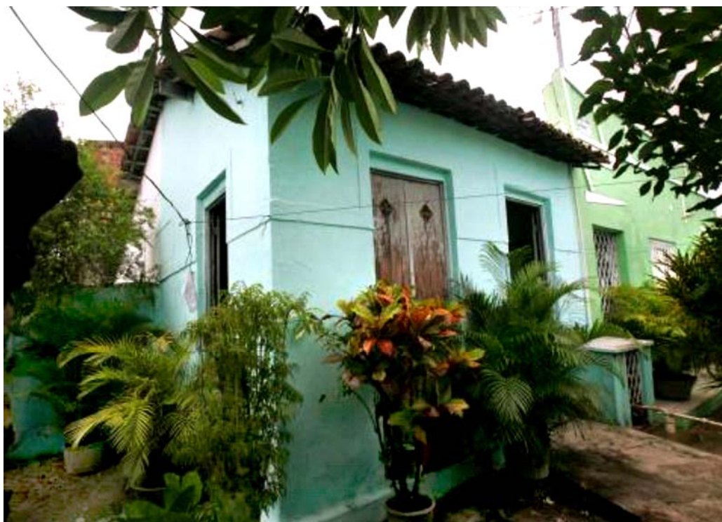
Figura 25 – Casa de portas de fichas, detalhe de ferro, piso de cimento e teto de lambris, na Vila Demóstenes Rockert, em Fortaleza (CE).
