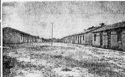
Rua de casas Tipo «A»
