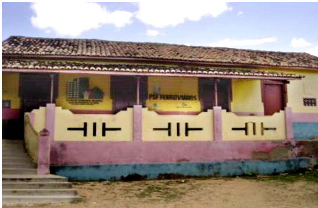
Figura 5 – Na antiga residência do gerente de depósito da RVC/RFFSA, em Cedro (CE), funciona nos dias atuais o PSF Ferroviários. Foto do autor (26/12/2008)/Acervo do autor.
