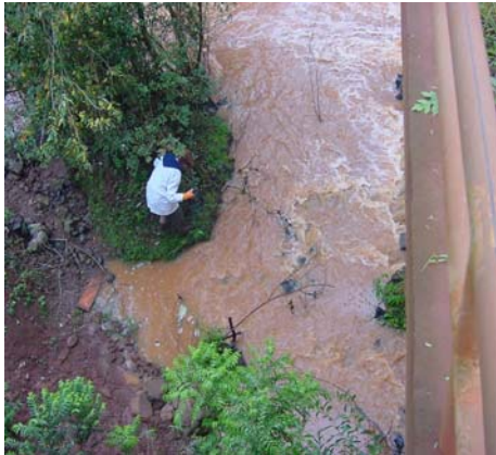
FIGURA 16-ASPECTO GERAL DO PONTO P05
