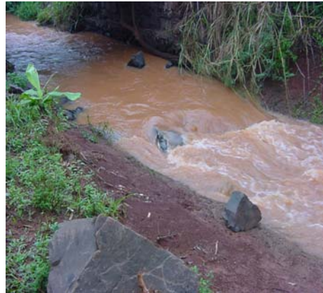
FIGURA 17- ASPECTO GERAL DO PONTO P06
